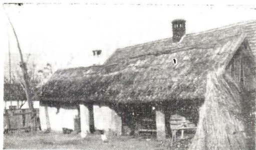
Grajd cu „Șofru“, pe piloni din pământ bătut, construit pe la 1840—1850, Cenad jud. Timiș.
