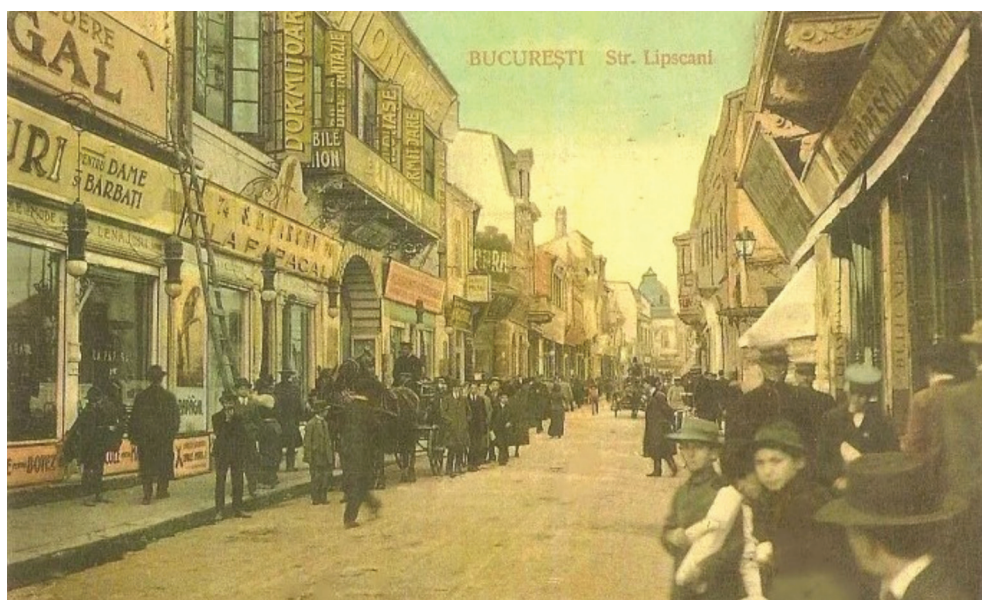
Figura 10. Lipscani nr. 90, fost nr. 76, La Papagal (Albert S. Farchy). Spațiul magazinului aflat în proprietatea M.S. Ascher (Lipscani nr. 74-76) se afla lângă Pasajul comercial. A fost puternic afectat de cutremurul din 1977 și demolat.
