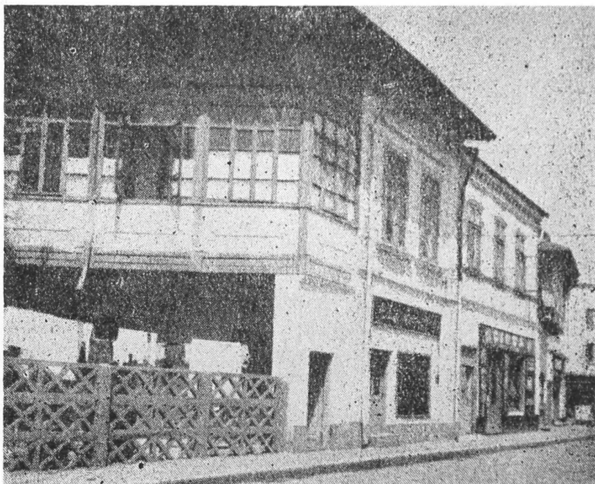
Fig. 6. Case de locuit din zona centrală a orașului.
