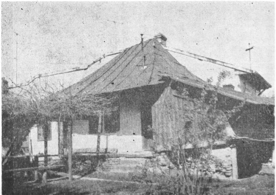
Fig. 11. Casă de locuit — sec. XIX, str. N. Bălcescu nr. 312 (disprețurată).
