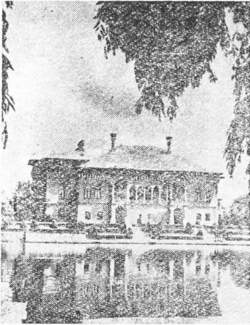
Fig. 3. Palatul de la Mogoșoaia. Fațada de vest.
