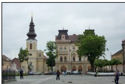
Biserica ortodoxă sârbă cu hramul Sfântul Mare Mucenic Gheorghe. A fost construită în anul 1746, alături - Casa Comunității Sârbe
