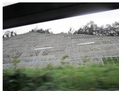
Consolidarea unui deal, pentru protejarea șoselei
