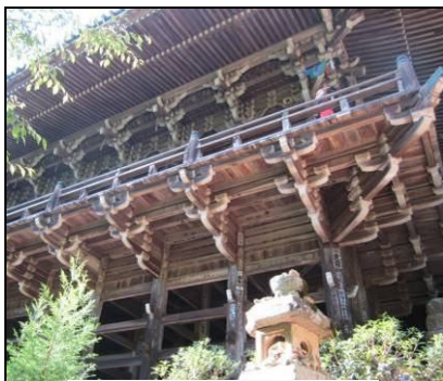
Arhitectură medievală în lemn, la Templul Engyo-ji, de pe Muntele Shosha
