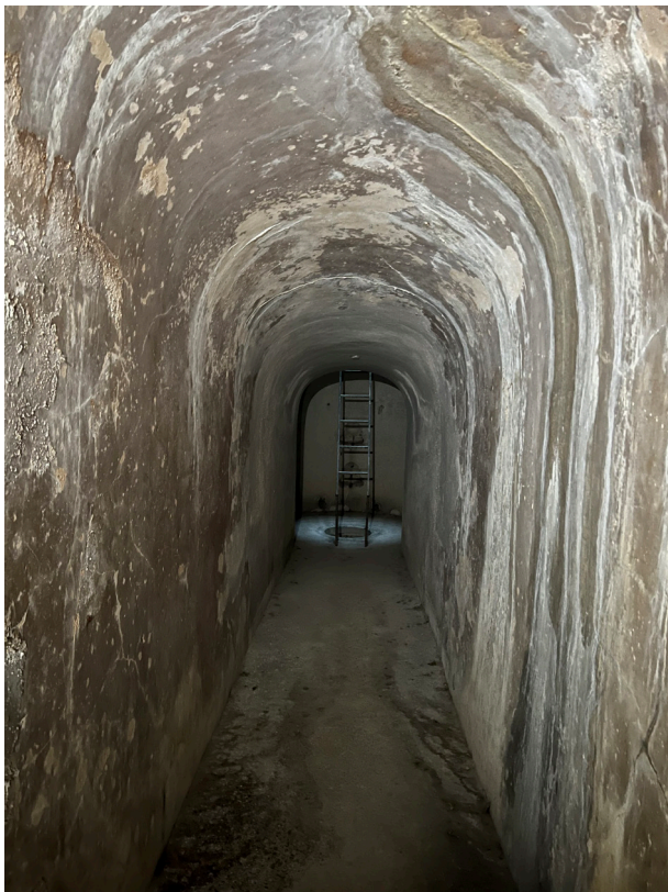
Il. 13. Couloir desservant l'espace de gestion d'eaux. (Source: collections Andreea Ember).
