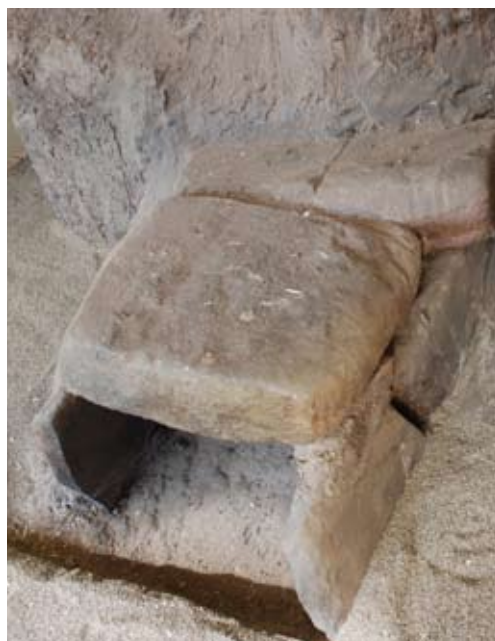
Foto 8. Gura cuptorului după restaurare (detaliu)
