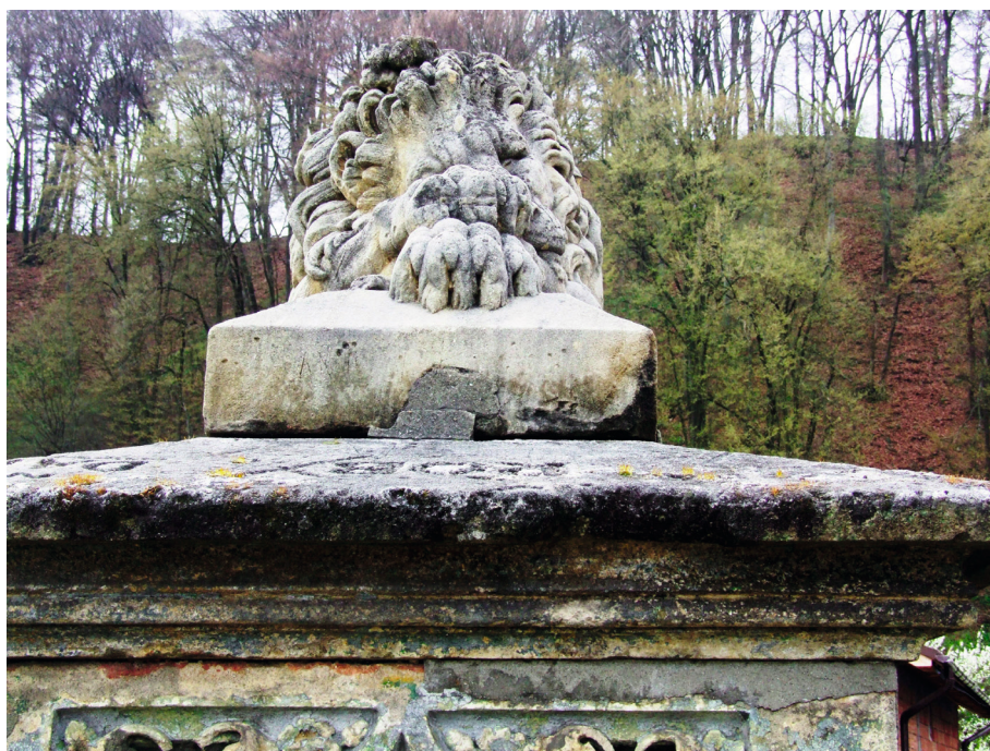
Monumentul Skariatina în situația actuală-vedere frontală către Sud
