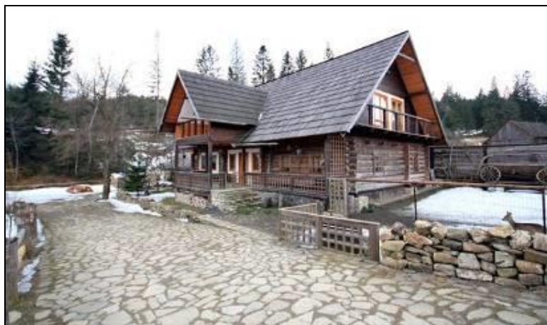
Pensiunea „Casa Bunicilor”, Mănăstirea Humorului. Pe terenul pensiunii sunt trei case vechi strămutate și adaptate la nevoile specifice ale turiștilor: Casa Starciuc, Casa Sereidiuc și Casa Irinucăi. Sursa: Arhiva personală Carmen Chașovschi.
