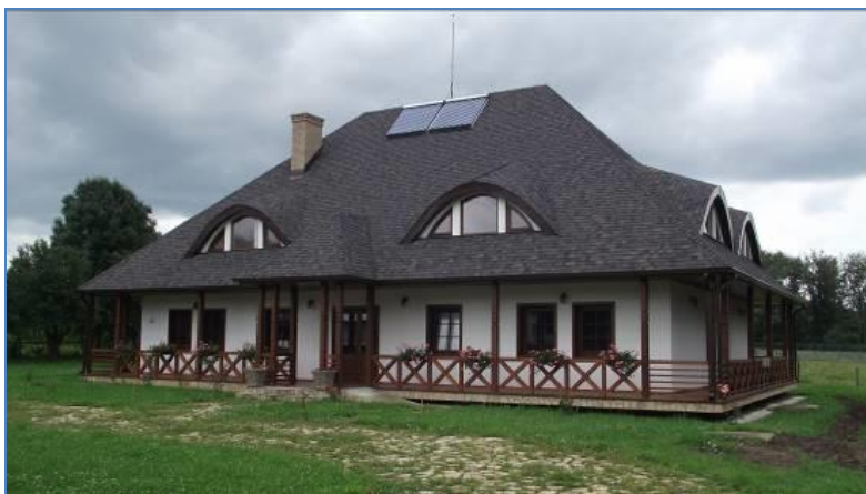
Casă nouă în Cacica, care va funcționa ca centru meșteșugăresc. Sursa: Arhiva personală Carmen Chașovschi.
