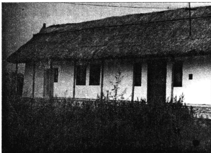
Casă românească cu plan dezvoltat; prispă la fațada principală; acoperită cu stuf. (zona Dunării).
