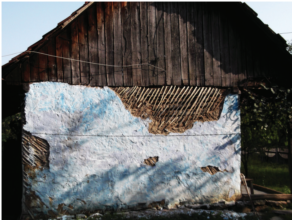
Fig. 1: Peretele casei recercuit
