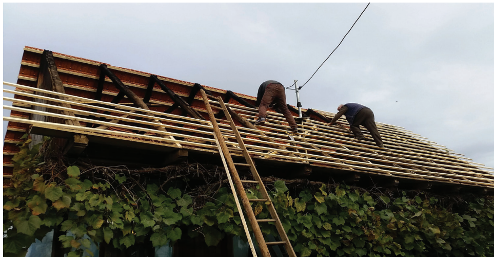
Fig. 3: Maistorii schimbă acoperișul casei
