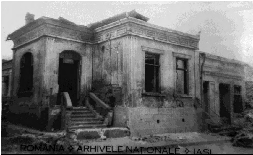
Fig. 2. The building on Dimitrov Street 121 in the aftermath of the earthquake in March 1977 (Source: AN Iași, Colecția de Stampe și Fotografii, 5981, f. 17)
