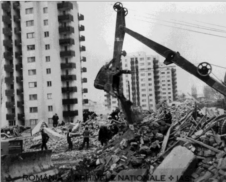
Fig. 3. Demolition on Dimitrov Street in the aftermath of the earthquake in 1977. The tower-blocks are completed (Source: AN Iași, Colecția de Stampe și Fotografii, 5981, f. 12)
