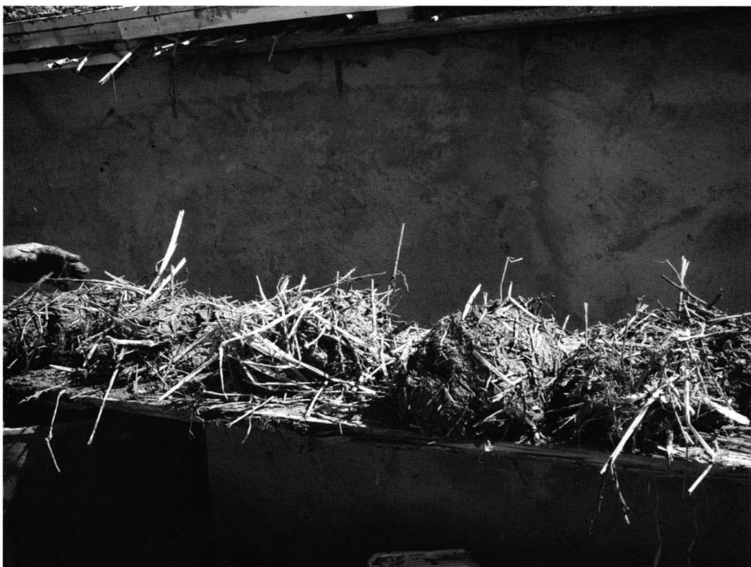
Ciobanu – Tehnica de construcție cu „cocoloașe de ceamur”
