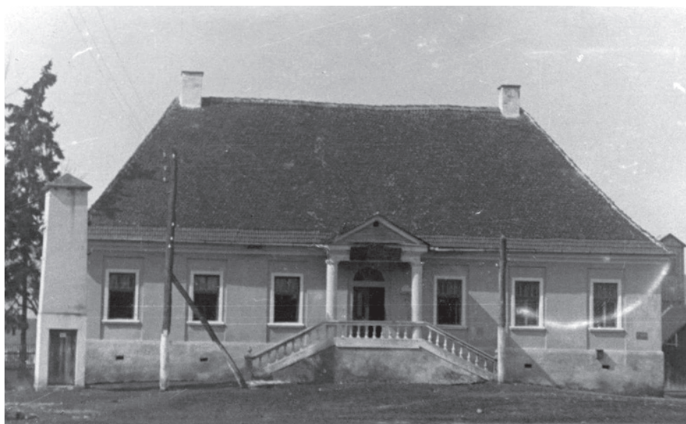
Foto. 10 – Sediul Primăriei comunei Iad – 1935
