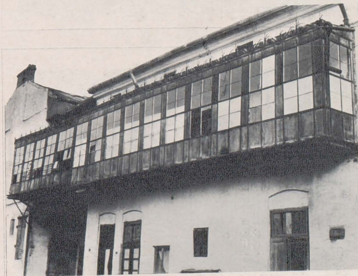
Fațada spre stradă a unei locuințe adiacente unui imobil de magazine din Botoșani, sfîrșitul sec. XIX. În execuția pridvorului închis s-au utilizat profile de fier și panouri de tablă. Această soluție arhitectonică este des întîlnită în construcțiile moderne cu mai multe etaje — de fapt, un mur-rideau redus (foto arh. C. Joja).
