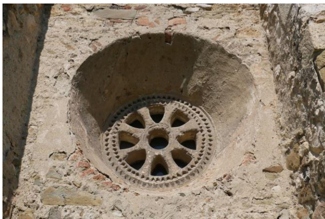
Figura 3: Fereastra circulară romanică din partea de Est (Sursă: Documentația foto din proiectul de restaurare)
