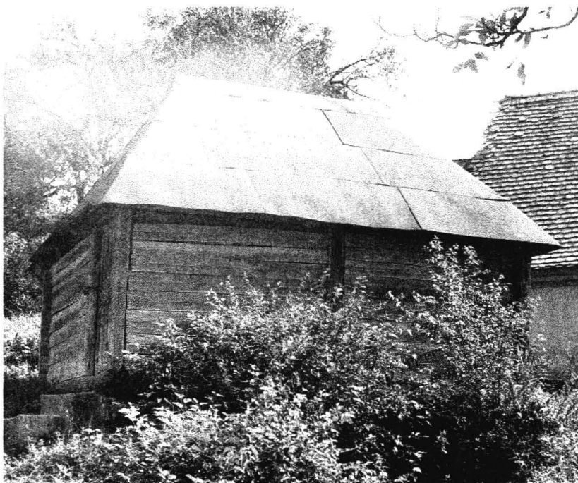
Figure 14. Un moulin de Ilidia avec des murs renforcées avec de piliers verticaux.
