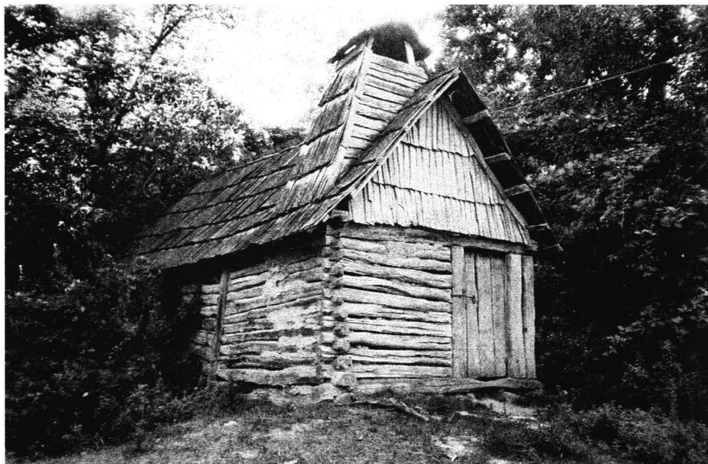
Figure 8. Le moulin de la vallée de Cameniţa (Il faut remarquer le système d'évacuation de la fumée).
