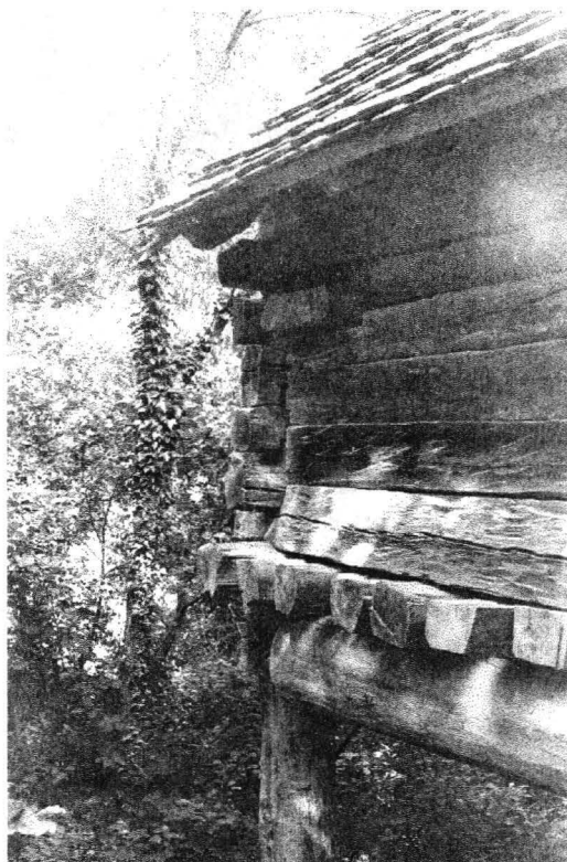
Figure 21. Détails constructifs du moulin Humișasca: assemblage en broche et sustentation sur des piliers.
