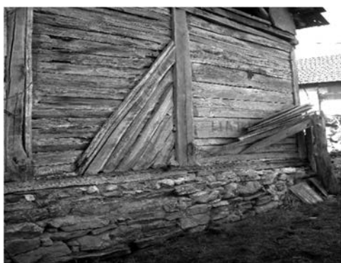
Fig. 24 – Detaliu de îmbinări – casă din Izbuc, nr. 179 49
