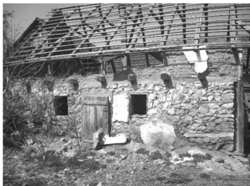
Fig. 26 – Structura acoperișului – casă din Călugări, nr. 215
