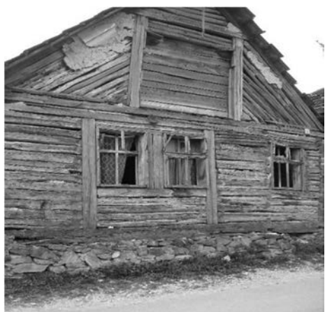
Fig. 42 – Structură de rezistență mixtă, cu stâlpi și bărne îmbinate cu „chiotori” – Seghiște, nr. 11
