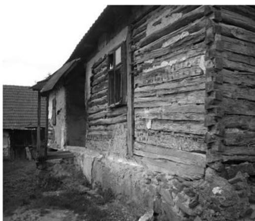
Fig. 42 – Structură de rezistență mixtă, cu stâlpi și bărne îmbinate cu „chiotori” – Seghiște, nr. 11
