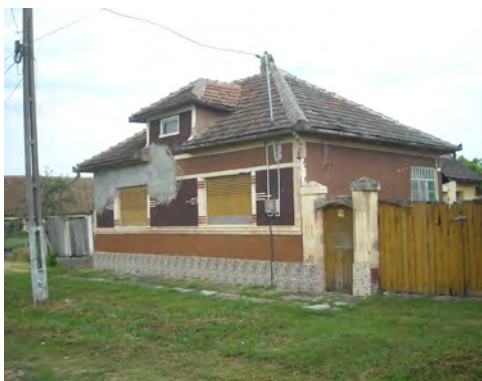
Fig. 26. Casa nr. 119 – paralelă cu axa uliței, tindă, două camere și coridor închis; acoperiș în 4 ape; zidăria de cărămidă, acoperită cu tencuială, cu decorațiuni (ulița principală)
