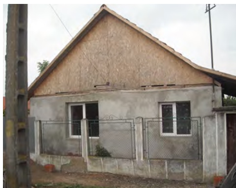
Fig. 13. Casa nr. 109 (în curs de renovare) – perpendiculară cu axa uliței, 2 camere și tindă, târnaț închis ulterior, acoperiș în 2 ape; zidăria de văioagă acoperită cu tencuială nouă; ferestre din termopan; calcanul refăcut din plăci OSB (ulița „în doalmă”)
