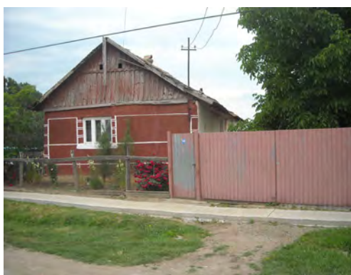
Fig. 15. Casa nr. 144 – perpendiculară cu axa uliței, 2 camere și tindă, târnaț cu stâlpi zidiți, închis ulterior, acoperiș în 2 ape; zidăria de văioagă acoperită cu tencuială; fațada cu decorațiuni; calcanul din scânduri (ulița principală)
