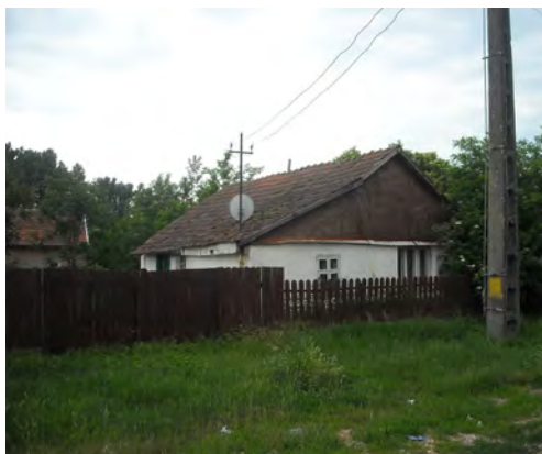
Fig. 22. Casa nr. 347 – perpendiculară cu axa uliței, o cameră și tindă, târnaț închis ulterior, apoi extins, acoperiș în 2 ape; zidăria de văioagă; calcanul din scânduri (ulița romilor)
