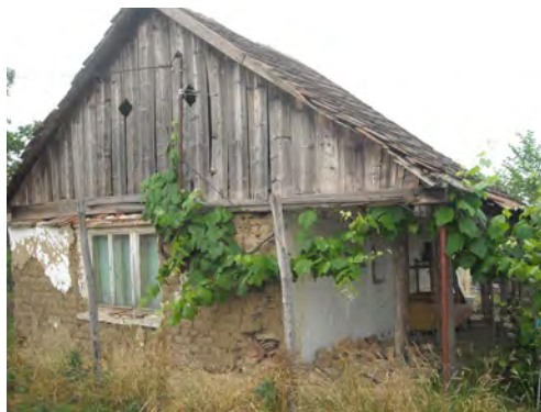
Fig. 18. Casa nr. 102 (în paragină) – perpendiculară cu axa uliței, o cameră și tindă, târnaț cu stâlpi de lemn, acoperiș în 2 ape; zidăria de văioagă acoperită cu lut; calcanul din scânduri (ulița „în doalmă”)
