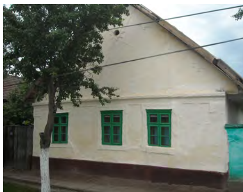
Fig. 16. Casa nr. 151 – perpendiculară cu axa uliței, 2 camere și tindă, târnaț cu stâlpi zidiți, închis ulterior, acoperiș în 2 ape; zidăria de văioagă acoperită cu lut ( lipită cu tină ); fațada și calcanul decorate cu muluri (ulița principală)
