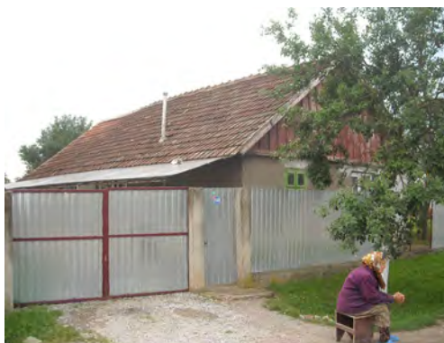
Fig. 20. Casa nr. 149 – perpendiculară cu axa uliței, o cameră și tindă, târnaț închis ulterior, acoperiș în 2 ape; zidăria de văioagă acoperită cu tencuială; calcanul din scânduri (ulița principală)
