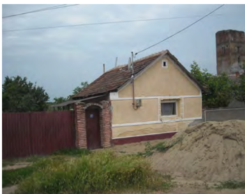
Fig. 19. Casa nr. 87 – perpendiculară cu axa uliței, o cameră și tindă, târnaț închis ulterior, acoperiș în 2 ape; zidăria de văioagă acoperită cu tencuială; calcanul la fel (ulița „la pod”)
