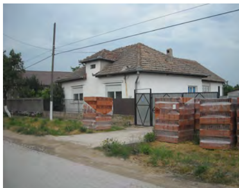
Fig. 24. Casa nr. 12 – paralelă cu axa uliței, tindă, două camere și coridor închis; acoperiș în 4 ape; zidăria de cărămidă, acoperită cu tencuială; o extensie ulterioară înspre curte (ulița principală)
