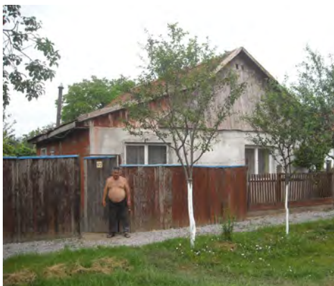
Fig. 21. Casa nr. 172 – perpendiculară cu axa uliței, o cameră și tindă, târnaț închis ulterior, apoi extins cu zidărie de cărămidă, acoperiș în 2 ape; pereții edificați pe stâlpi de lemn și nuietele împletite, acoperiți cu lut; calcanul din scânduri (ulița principală)
