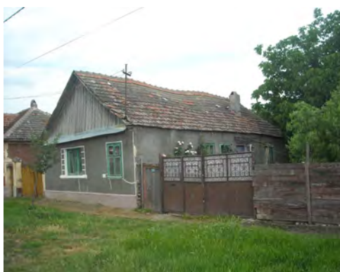
Fig. 14. Casa nr. 118 – perpendiculară cu axa uliței, 2 camere și tindă, târnaț închis ulterior, acoperiș în 2 ape; zidăria de văioagă acoperită cu tencuială; calcanul din scânduri (ulița principală)
