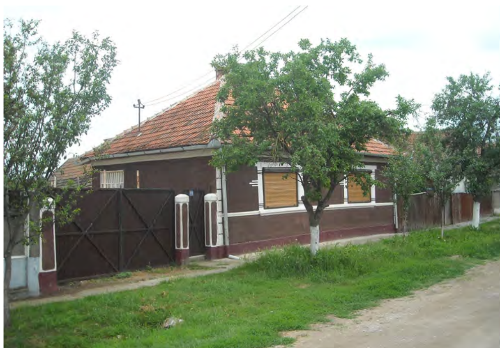
Fig. 11. Casa nr. 173 – paralelă cu axa uliței, în vinclu, coridor închis, tindă, două camere, cămară; zidăria de cărămidă, acoperită cu tencuială, decorată cu muluri, acoperișul în 4 ape (ulița principală)
