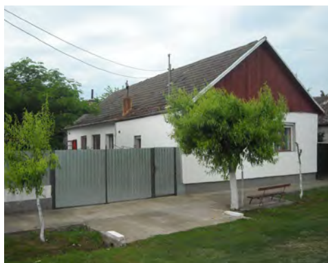
Fig. 17. Casa nr. 167 – perpendiculară cu axa uliței, 2 camere și tindă, târnaț cu stâlpi zidiți, închis ulterior, acoperiș în 2 ape; zidăria, de văioagă și pământ bătut, acoperită cu tencuială și parțial izolată cu polistiren; calcanul din scânduri, (ulița principală)
