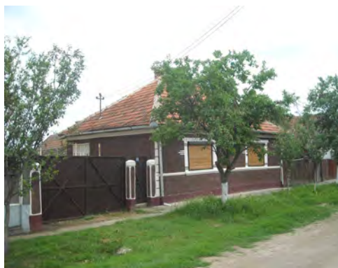
Fig. 31. Casa nr. 173 – paralelă cu axa uliței, în vinclu, coridor închis, tindă, două camere, cămară; zidăria de cărămidă, acoperită cu tencuială, decorată cu muluri, acoperișul în 4 ape (ulița principală)
