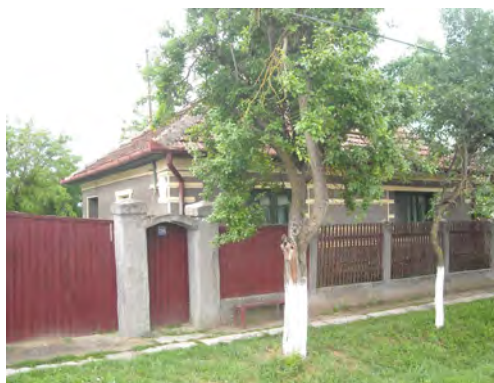
Fig. 30. Casa nr. 154 – paralelă cu axa uliței, în vinclu, coridor închis, tindă, două camere, cămară; zidăria de cărămidă, acoperită cu tencuială, decorată cu muluri, acoperișul în 4 ape (ulița principală)
