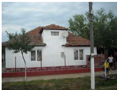
Fig. 27. Casa nr. 317 – paralelă cu axa uliței, tindă, două camere și coridor închis; acoperiș în 4 ape; zidăria de cărămidă, acoperită cu tencuială, (ulița romilor)
