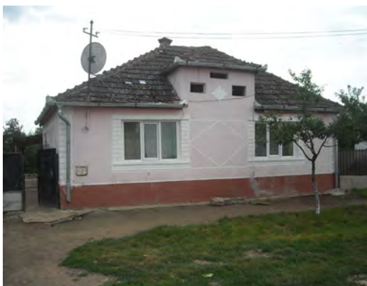
Fig. 28. Casa nr. 333 – paralelă cu axa uliței, tindă, două camere și coridor închis; acoperiș în 4 ape; zidăria de cărămidă, acoperită cu tencuială, decorată cu muluri (ulița romilor)
