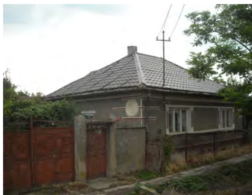
Fig. 32. Casa nr. 177 – paralelă cu axa uliței, în vinclu, coridor închis, tindă, două camere, cămară; zidăria de cărămidă, acoperită cu tencuială, decorată cu muluri, acoperișul în 4 ape (ulița principală)
