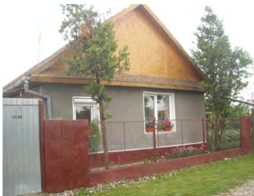
Fig. 12. Casa nr. 95 – perpendiculară cu axa uliței, 2 camere și tindă, târnaț închis ulterior, acoperiș în 2 ape; zidăria de văioagă tencuită; calcanul refăcut din plăci OSB (ulița „în doalmă”)
