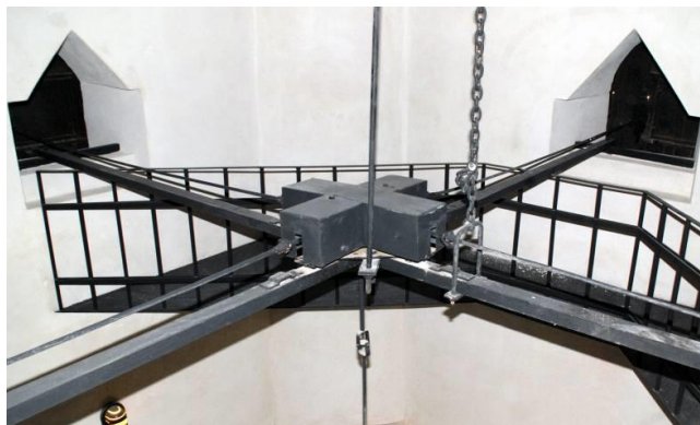
Fig. 7. Cutia de distribuție a mișcării la arătătoarele celor patru cadrane substituente și nepotrivite cu practica atelierului executant
