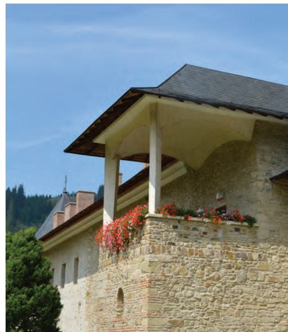
Mănăstirea Sucevița, foișorul de sud-est, reconstruire din beton armat aparent după proiectul Ioanei Grigorescu, vedere din 2016
