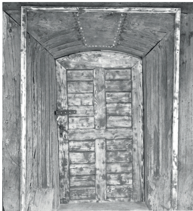
Fig. 3. Portalul exterior, foto: 2013.
