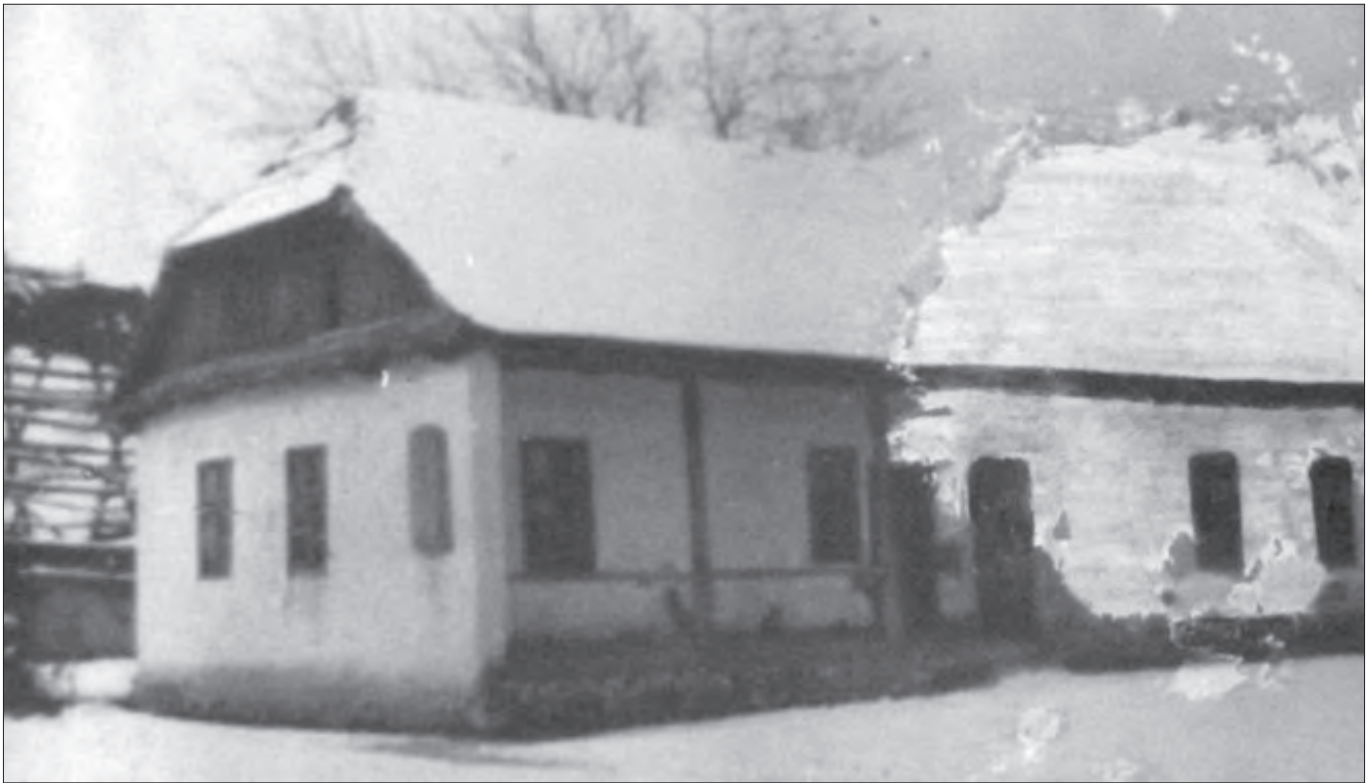
Clădirea școlii din Traniș care a funcționat între anii 1882 și 1955
