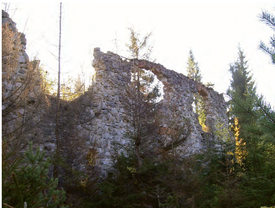
Fig. 123. Cavnic, Logolda . Ruinele clădirii instalației de preparare (foto C. Kacsó).
