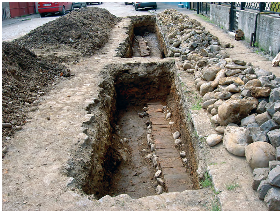
Fig. 33. Baia Mare, str. Dacia . Conductă de apă (foto C. Kacsó).
