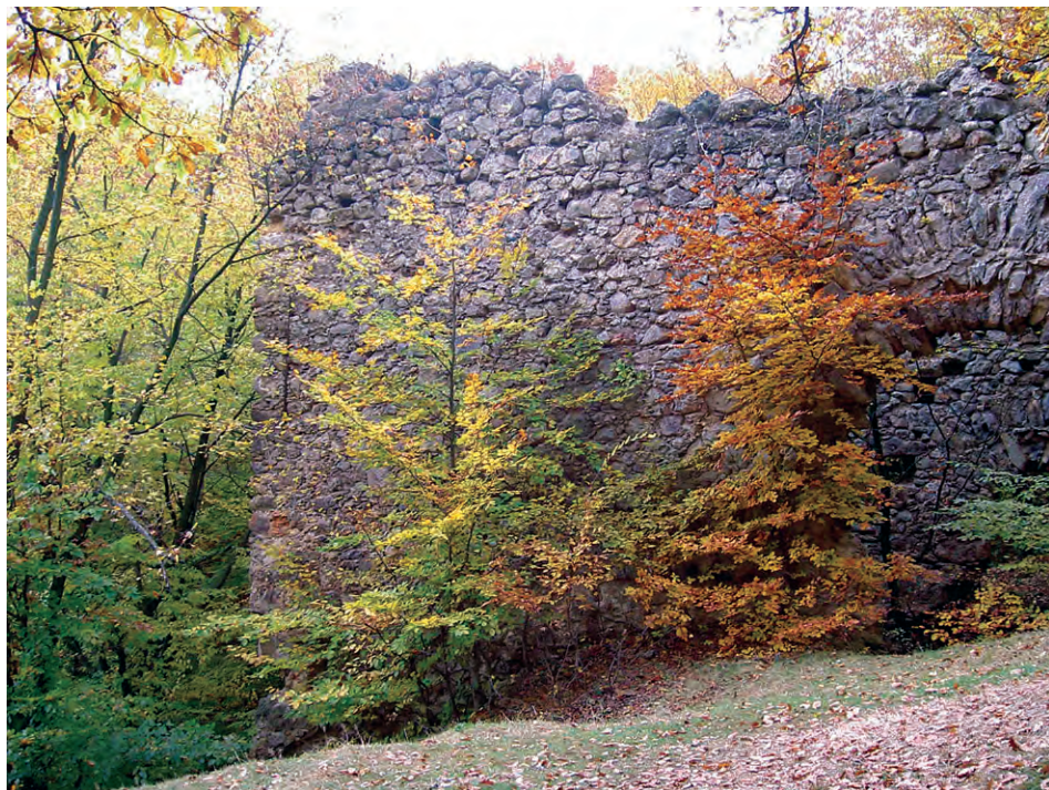
Fig. 63. Baia Sprie. Ruinele clădirii Puțului Francisc (foto C. Kacsó).
