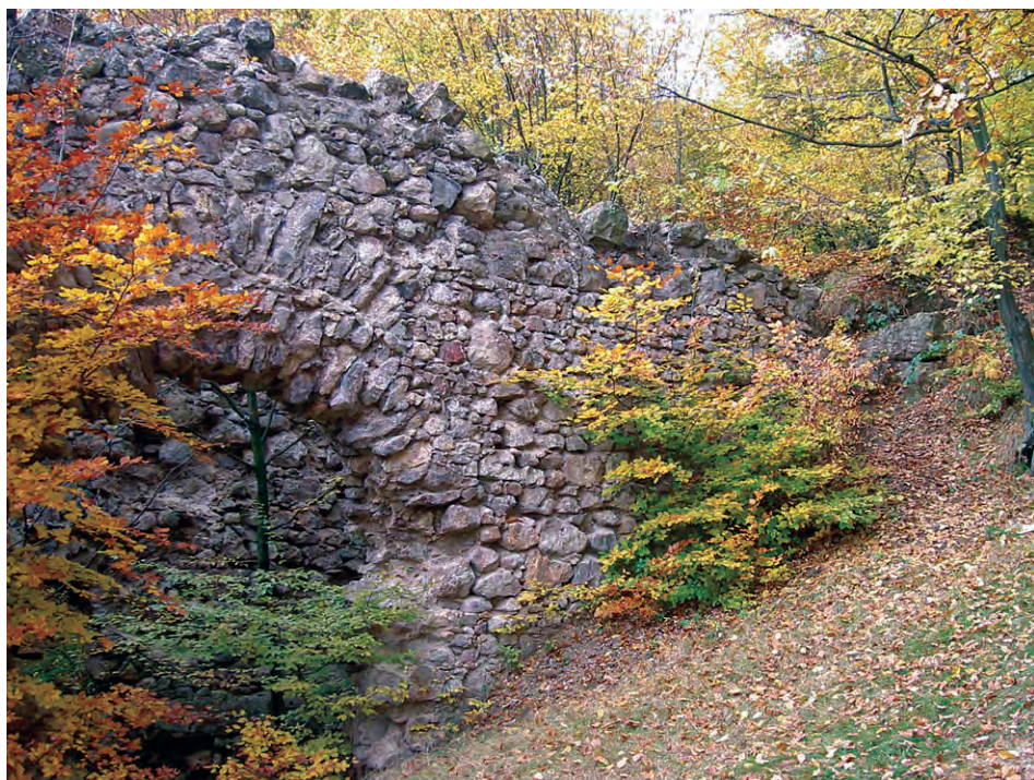
Fig. 62. Baia Sprie. Ruinele clădirii Puțului Francisc (foto C. Kacsó).
