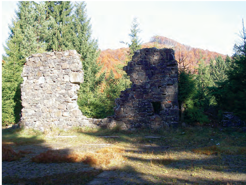
Fig. 122. Cavnic, Logolda . Ruinele clădirii instalației de preparare (foto C. Kacsó).
