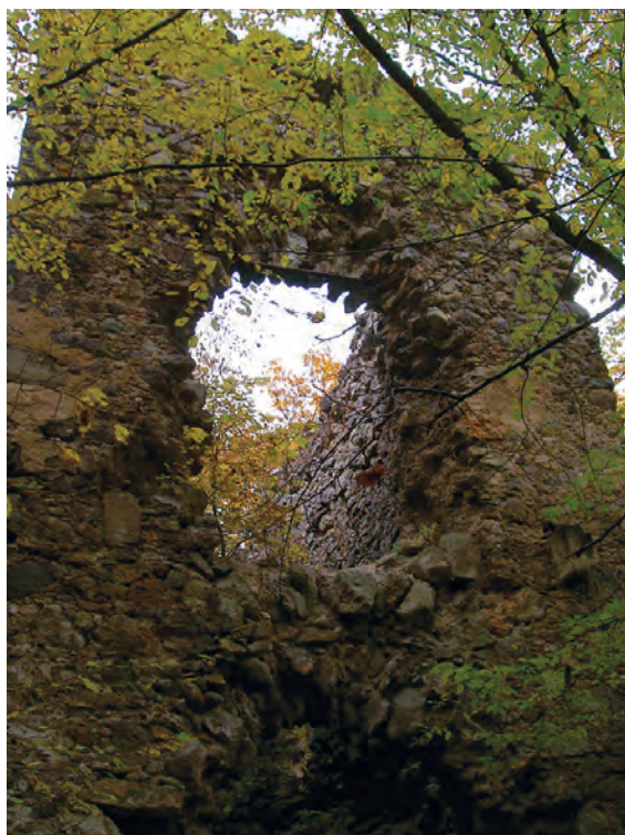
Fig. 64. Baia Sprie. Ruinele clădirii Puțului Francisc (foto C. Kacsó).
