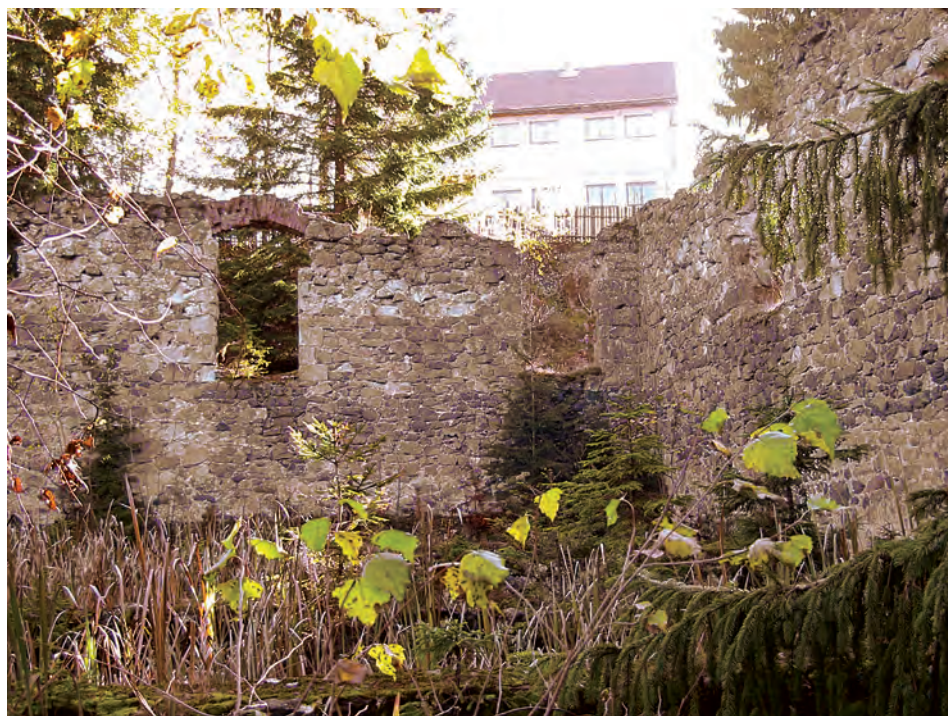
Fig. 121. Cavnic, Logolda . Ruinele clădirii instalației de preparare (foto C. Kacsó).
