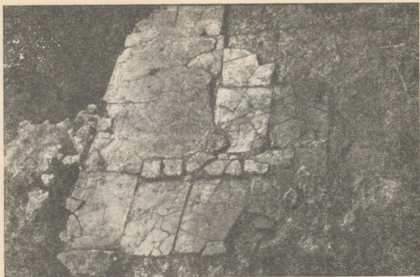
Fig. 30. Pardoseala veche găsită în interiorul basilicii mari, în colțul de sud-vest
