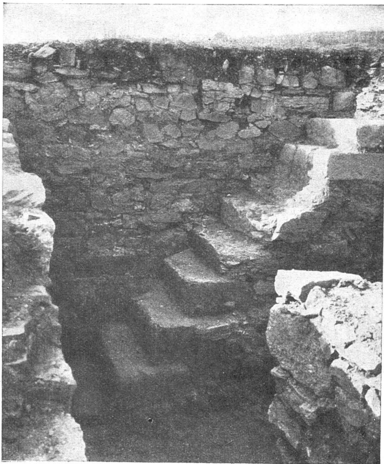
Soldații cari stăteau de strajă pe zid sau în turnuri se urcau sus, la posturile lor pe scări de piatră clădite în grosimea zidului cetății.
