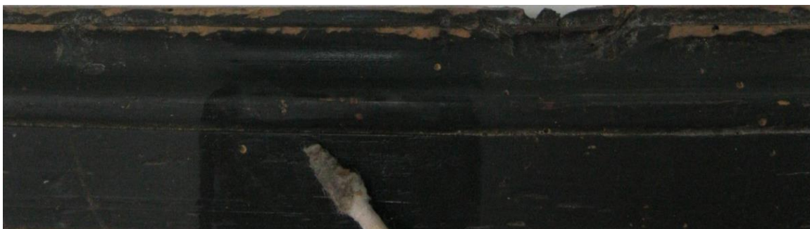
Aspecte din timpul curățirii chimice cu apă amoniacală la capac și ramă
