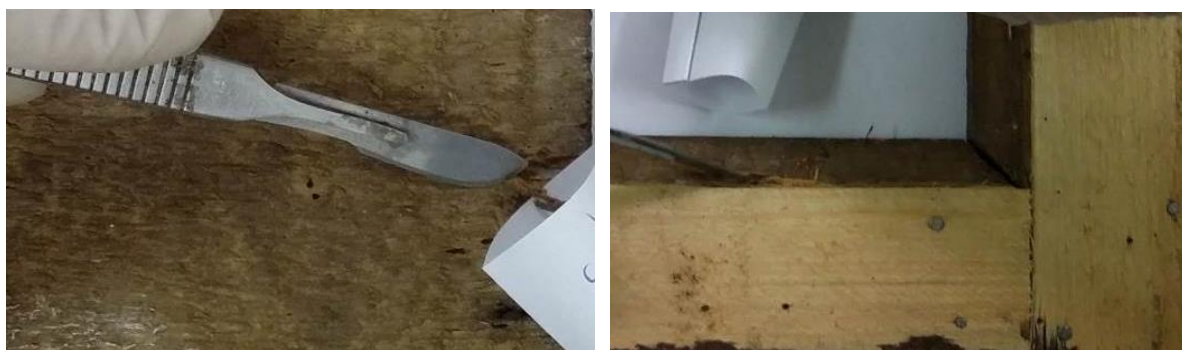
Aspecte din timpul prelevării probelor în vederea efectuării investigațiilor biologice la capac și ramă (din original)
