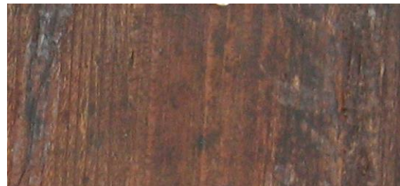
Detaliu din timpul consolidării și chituirii capacului
