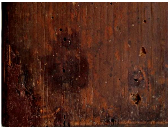
Aspect după consolidarea și chituirea capacului
