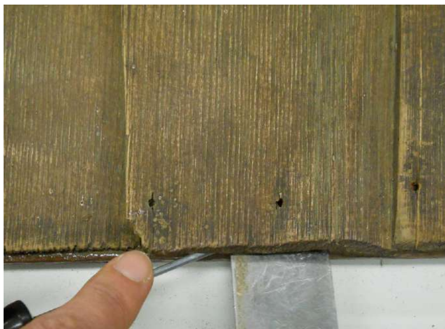
Aspecte din timpul demontării capacului
