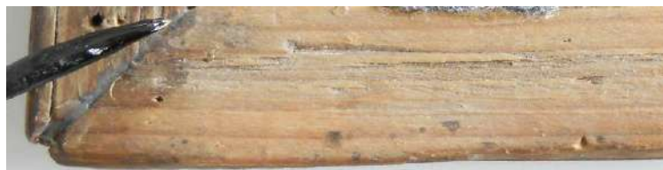
Detaliu din timpul consolidării îmbinărilor ramei
