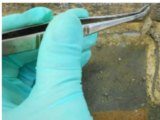
Aspect din timpul îndepărtării depozitelor de murdărie de pe suprafața peliculei de culoare
