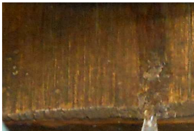
Aspect din timpul consolidării planșelor capacului
