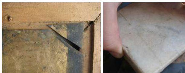
118. Detalii din timpul consolidării suportului
