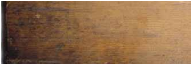
Aspect, după consolidarea capacului în zona fisurilor și după chituirea pierderilor de material lemnos
