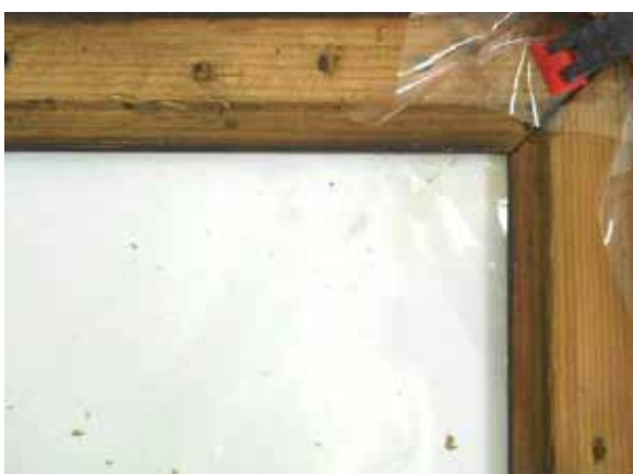
Aspect din timpul consolidării îmbinărilor ramei
