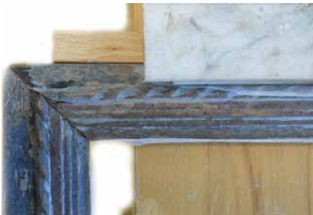
Aspect din timpul consolidării îmbinărilor ramei
