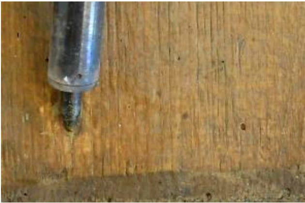
Aspect din timpul consolidării și chituirii capacului
