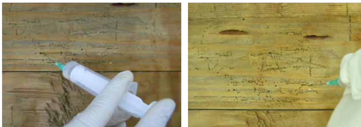
Detalii din timpul operației de dezinfecție cu Perxil 10, prin injectare
