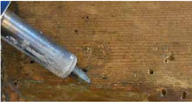
Aspect din timpul consolidării și chituirii capacului
