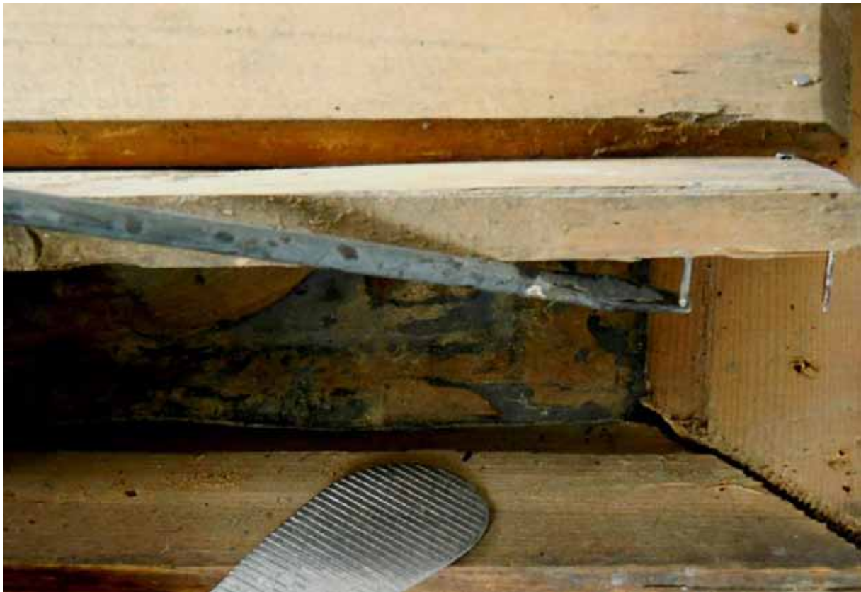
Aspect din timpul demontării capacului
