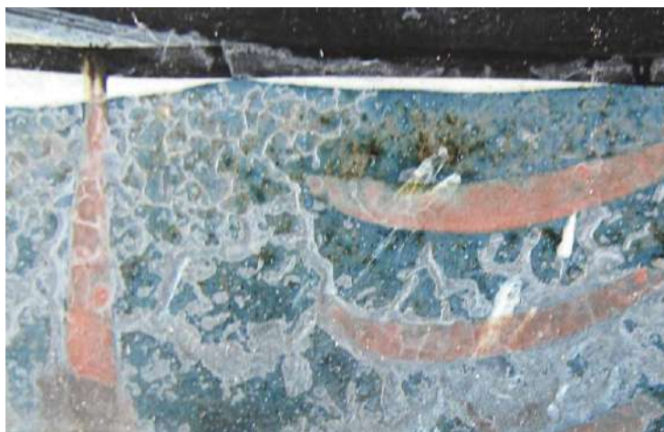
Degradări apărute în timp: murdărie aderentă și ancrasată; desprinderi și lacune ale peliculei de culoare; cracluri la nivelul pigmentului alb și pigmentului albastru
