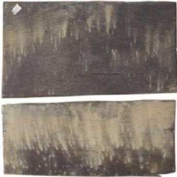
Ansamblu capac, înainte de operația de dezinfecție
