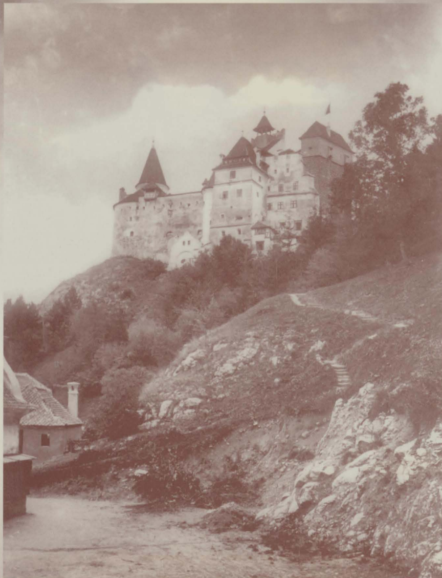
Fațada de Sud văzută dinspre vamă
