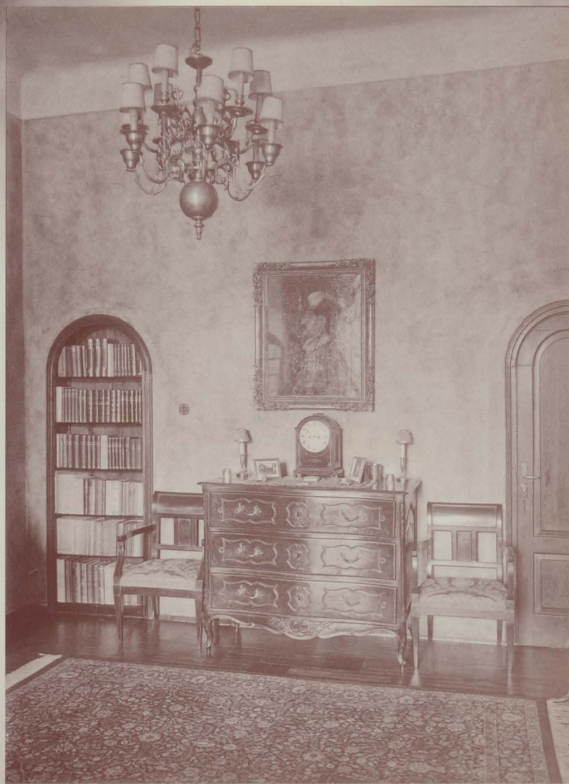
Interior din parterul casei de pe Calea Victoriei
