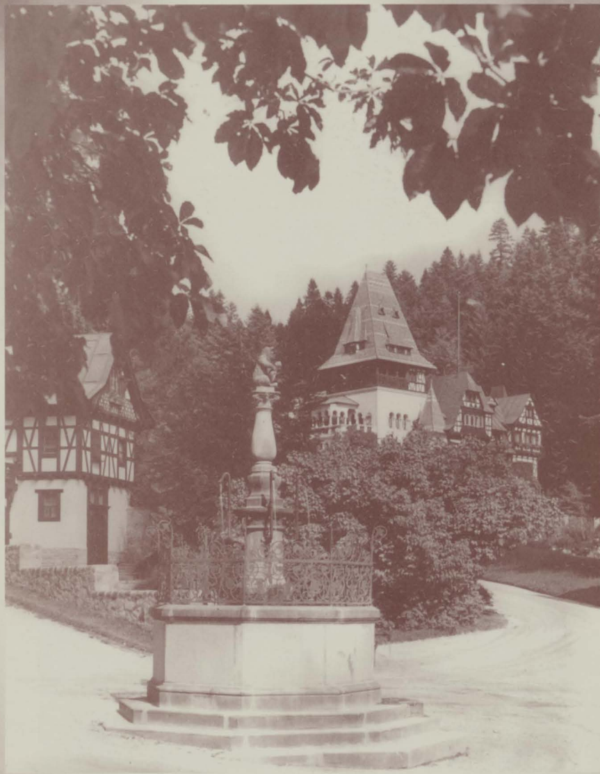
Aspect din Curtea Economatului cu casa arhitectului, în jurul anului 1903
