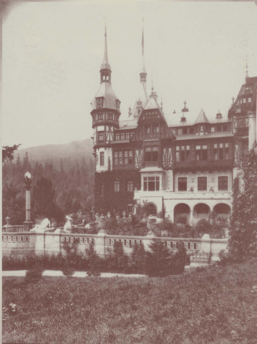
Vedere a Castelului dinspre est, înainte de anul 1914.
