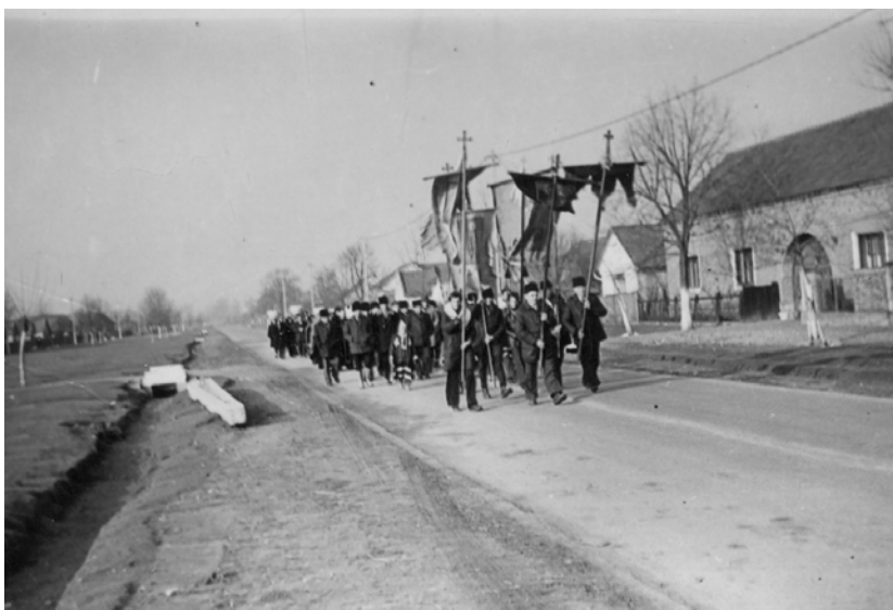
În fața convoiului, oameni cu prapori
