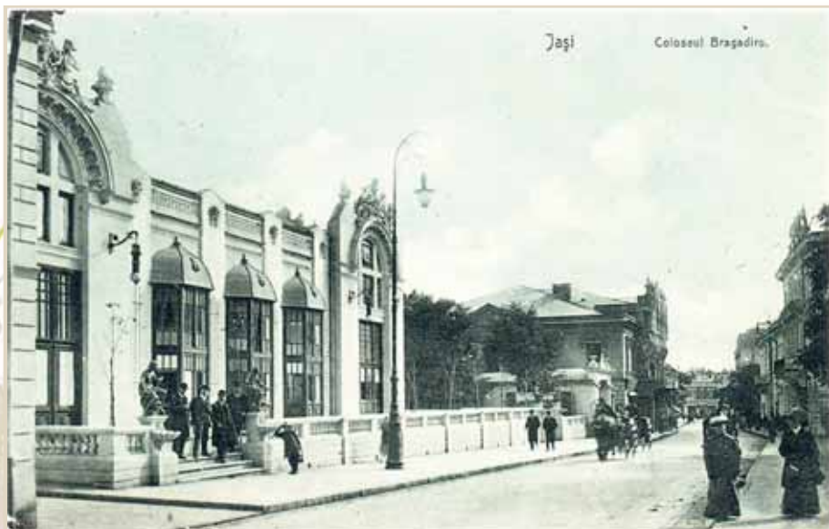
Coloseumul Bragadiru de pe strada Lăpușneanu (MI)
