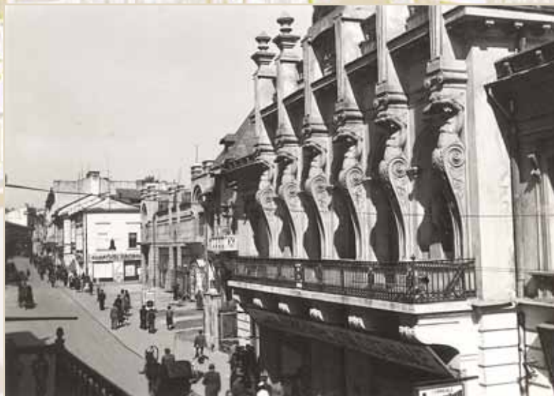
Fațada cu atlanți, amenajată la 1872 (INP)
