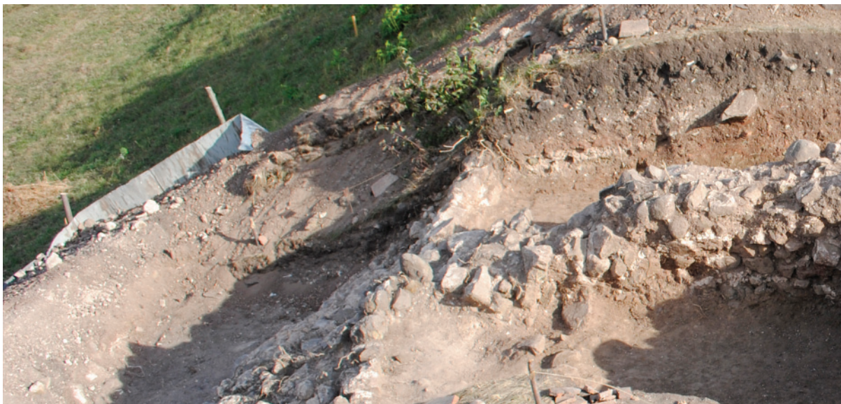
34 - JAC - jud. SJ - Porolissum - c1 - Bastionul de curtină de pe latura de nord
