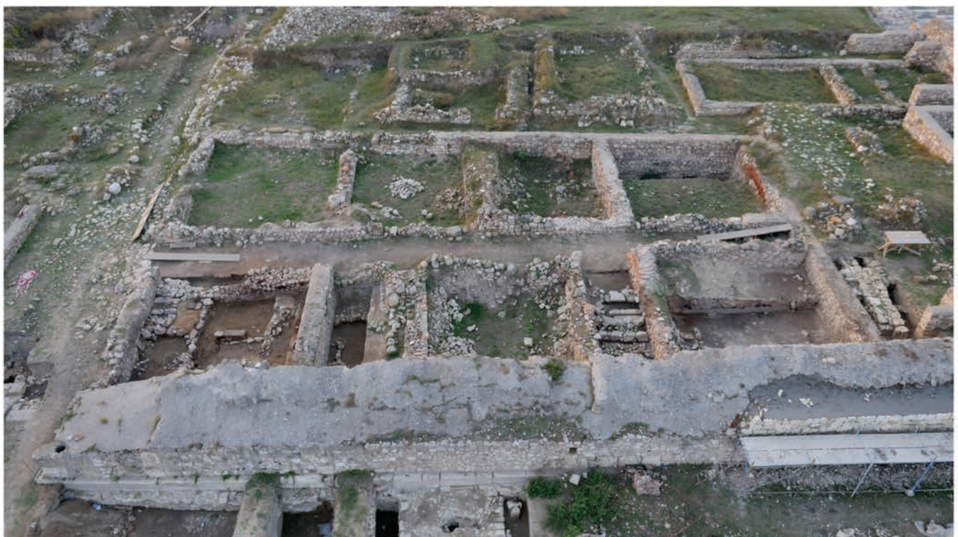
Planșa 14: Capidava 2015, Curtina G: Fotografii aeriene ale edificiului plasat în proximitatea curtinei G, realizate la finalul lucrărilor
