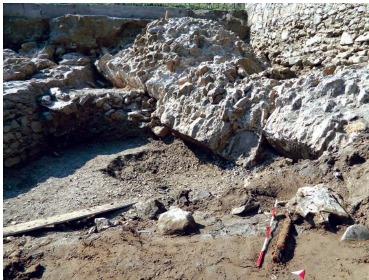
Foto 1. Turnul Spart – 2015. Fragment mare prăbușit din turn, suprapus de fundația casei contemporane și archebuză la descoperire (în prim plan)
