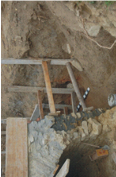
3. Cuptorul 1 etapă de lucru
