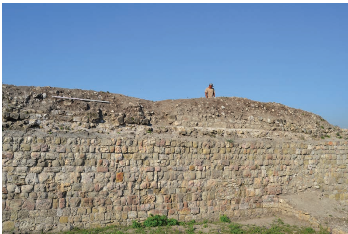
Fig. 8. Amenajarea zidului medio-bizantin: pe emplectonul de piatră cu mortar al curtinelor C-D (2009, 2015)
