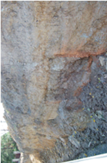
2. Cuptorul 1 în profilul secțiunii constructorilor
