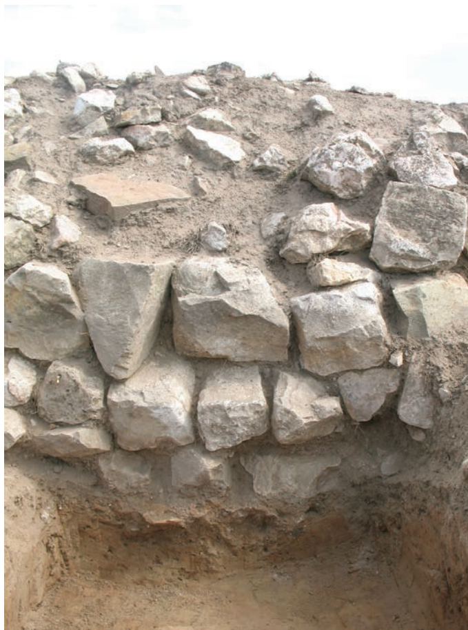
Fig. 7. Amenajarea zidului medio-bizantin: pe emplectonul de piatră cu mortar al curtinelor C-D (2009, 2015)
