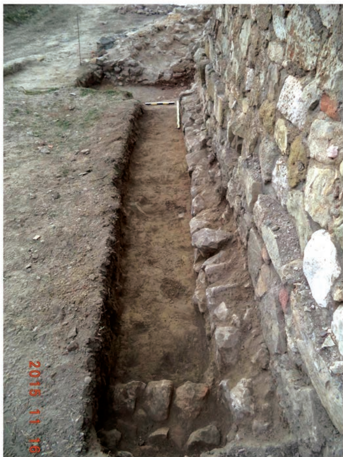
Fig. 6. Plinta curții H spre joncțiunea cu turnul 8
