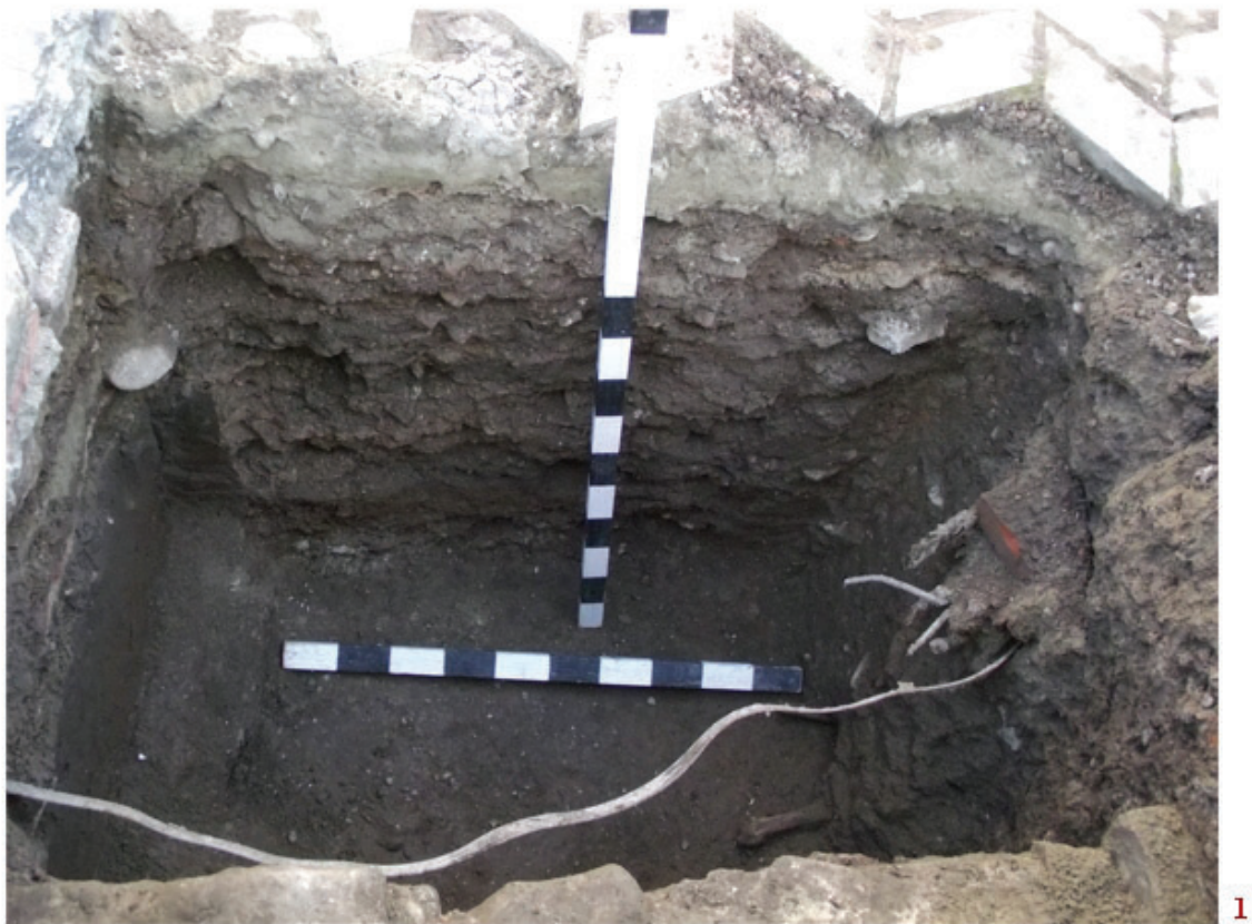
Fig. 4 – Curtea Domnească din Târgoviște, 2015, C 10 –1. Fundație incintă demantelată 2. C 12 Incinta demantelată și profil Est, 3. Zid incintă suprapus de Turnul Chindiei;
