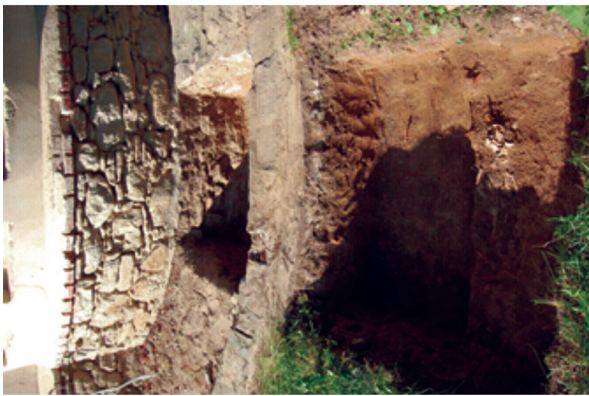
3. M2 - Exteriorul absidei nordice a naosului
