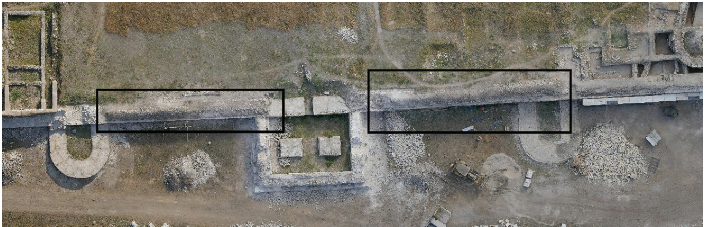
Fig. 5. Capidava – august 2015. Detaliu pe curtilele C-D (dreapta) și E (stânga), în zona de intervenție pe incinta medio-bizantine
