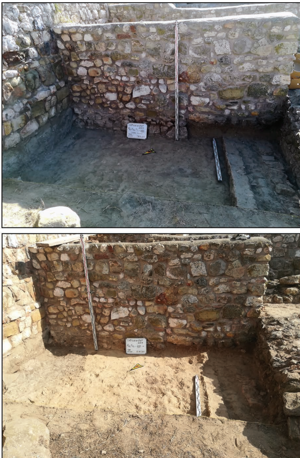
Fig. 6 - Încăperea C8A - conturarea canalului deversor C1.
