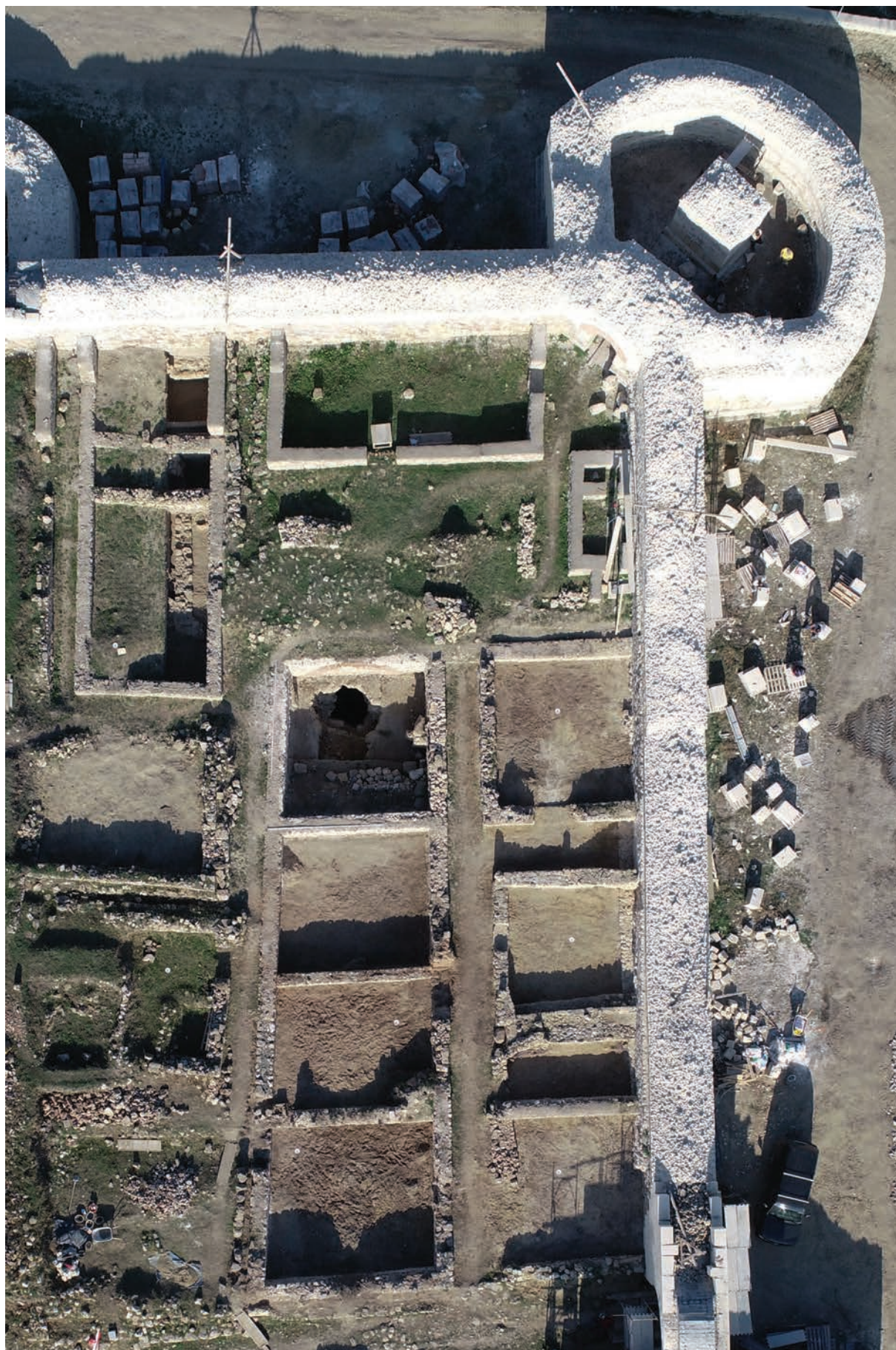
Fig. 13 - Lucrări de conservare - acoperirea încăperilor din edificiul E1.
