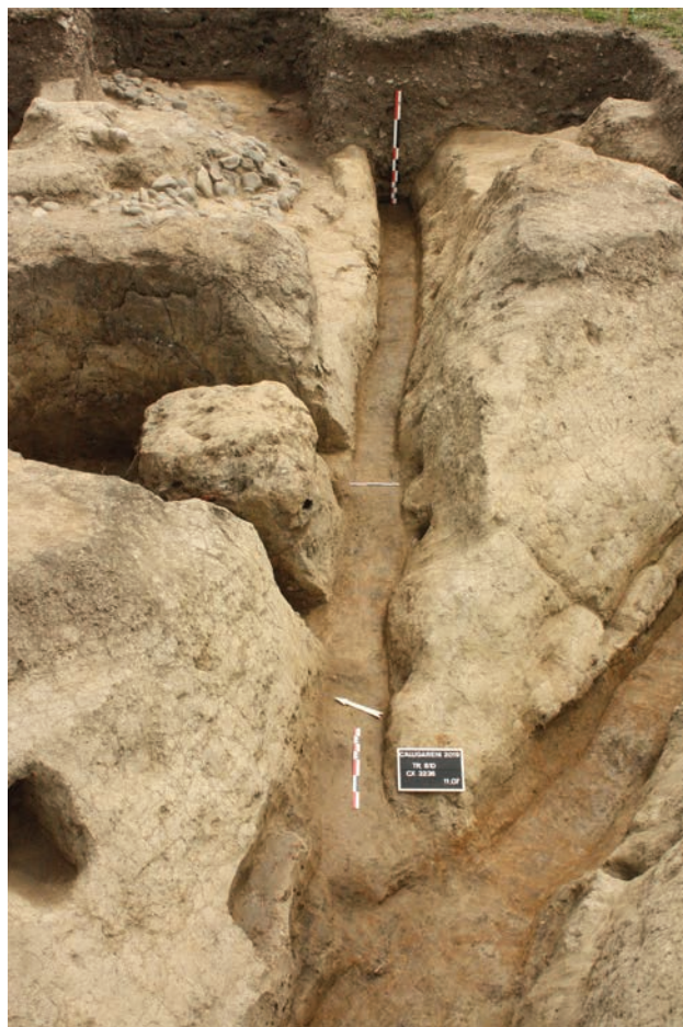
Fig. 6. Joncțiunea dintre canalele din terme
