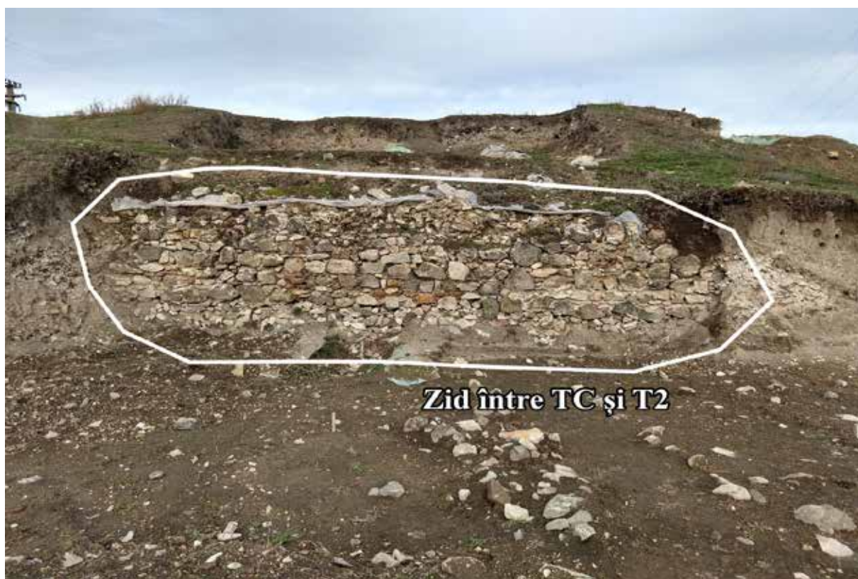
a. Delimitarea zidului medieval dintre Turnul de Colț și Turnul 2 (TA)
