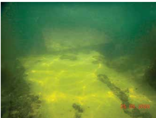
Fig. 3. Fotografie subacvatică a dalelor ce protejează canalul de scurgere.
