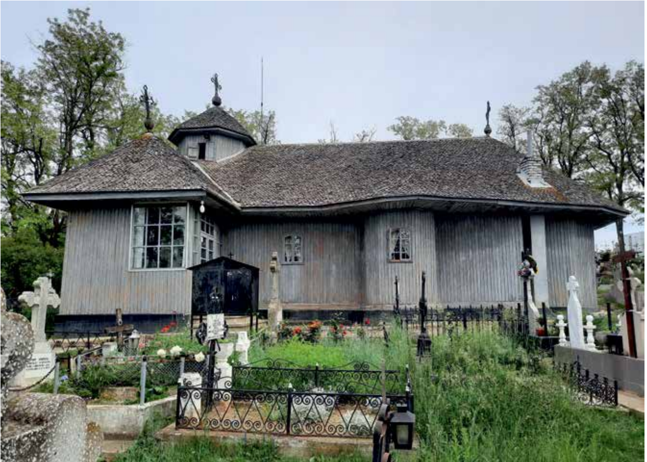
Fig. 1. Vedere generală dinspre sud (foto: C. Preoteasa, 2020).
