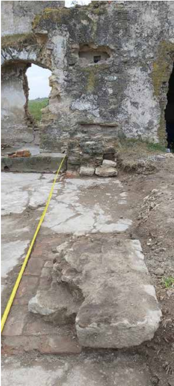
Fig. 7. Caseta C1 – detaliu stâlpi loggie.
