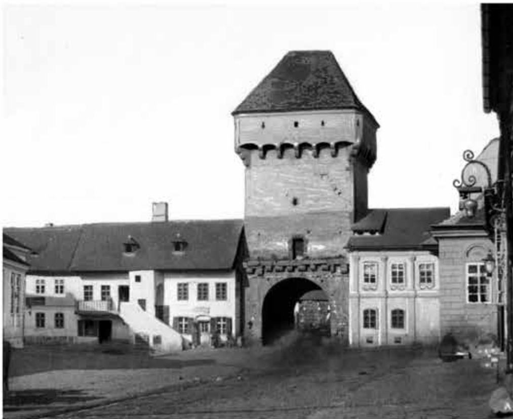
Planșa VI. Turnul de poartă dinspre nord (sus) și sud (jos). Fotografii realizate de Veress Ferenc în 1859.
