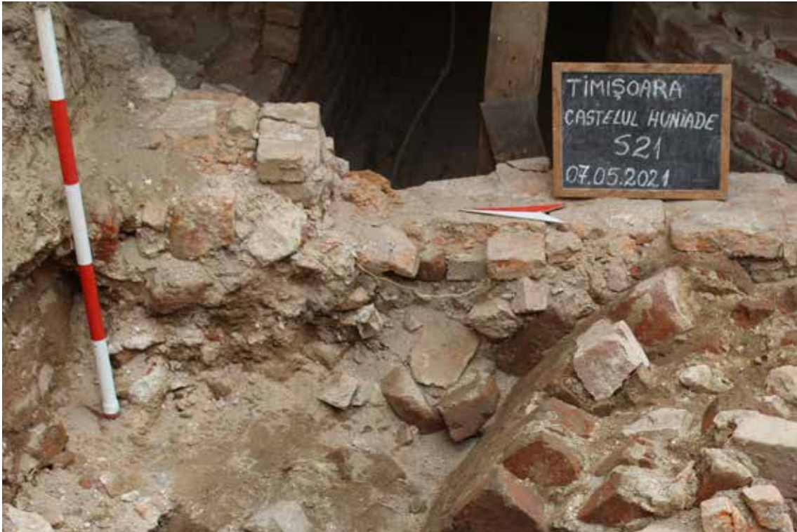
Fig. 6. Zidul prăbușit din turnul donjonului, vedere dinspre vest.
