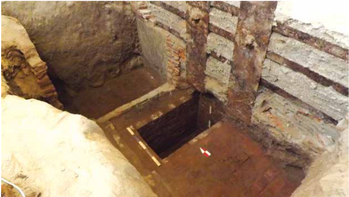
Fig. 4. S.28. Cripte tencuite, cu pavaj de cărămidă, afectate de intervențiile de secol XIX și de centura de beton a turnului.
