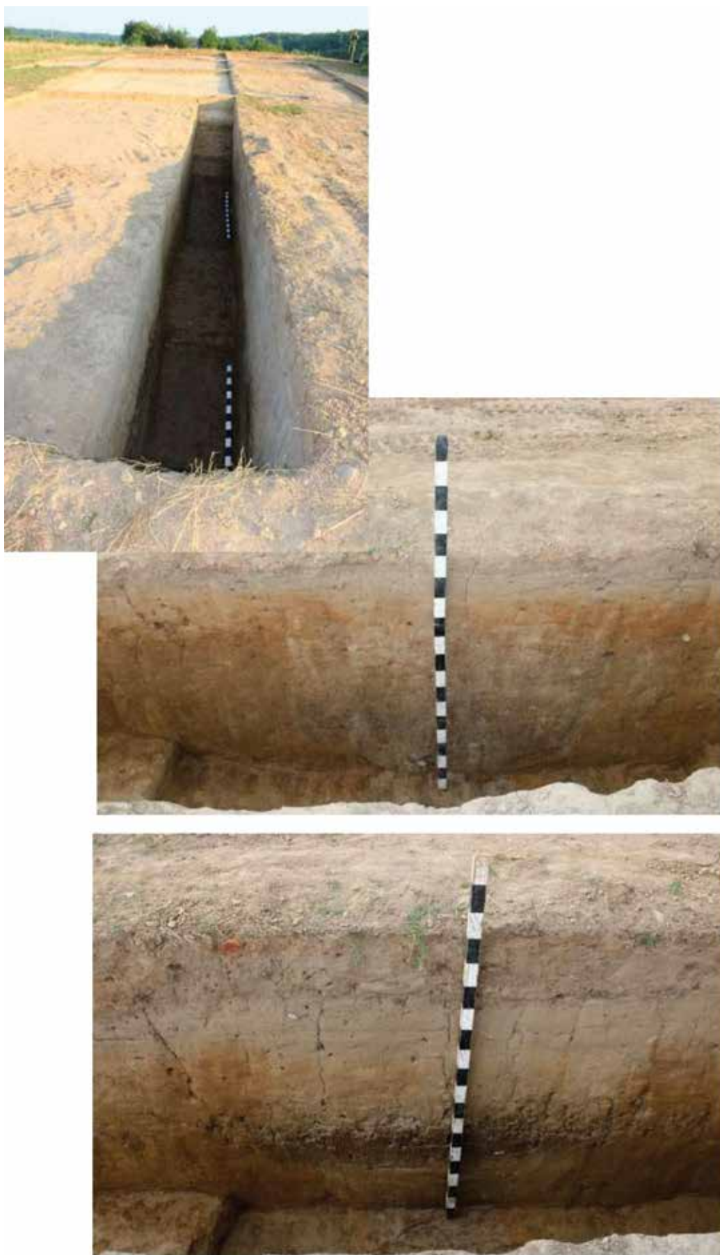
Pl. 3. Fotografii dinspre est spre vest, spre așezare, a S1/2021, unde au fost înregistrate cele două șanțuri de delimitare ale așezării și detalii cu primul, respectiv, al doilea șanț (foto A. Ilie).
