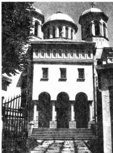
Biserica ortodoxă din Araci, ctitoria părintelui Aurel Nistor, afectată de cutremurele din 1977 și 1990
