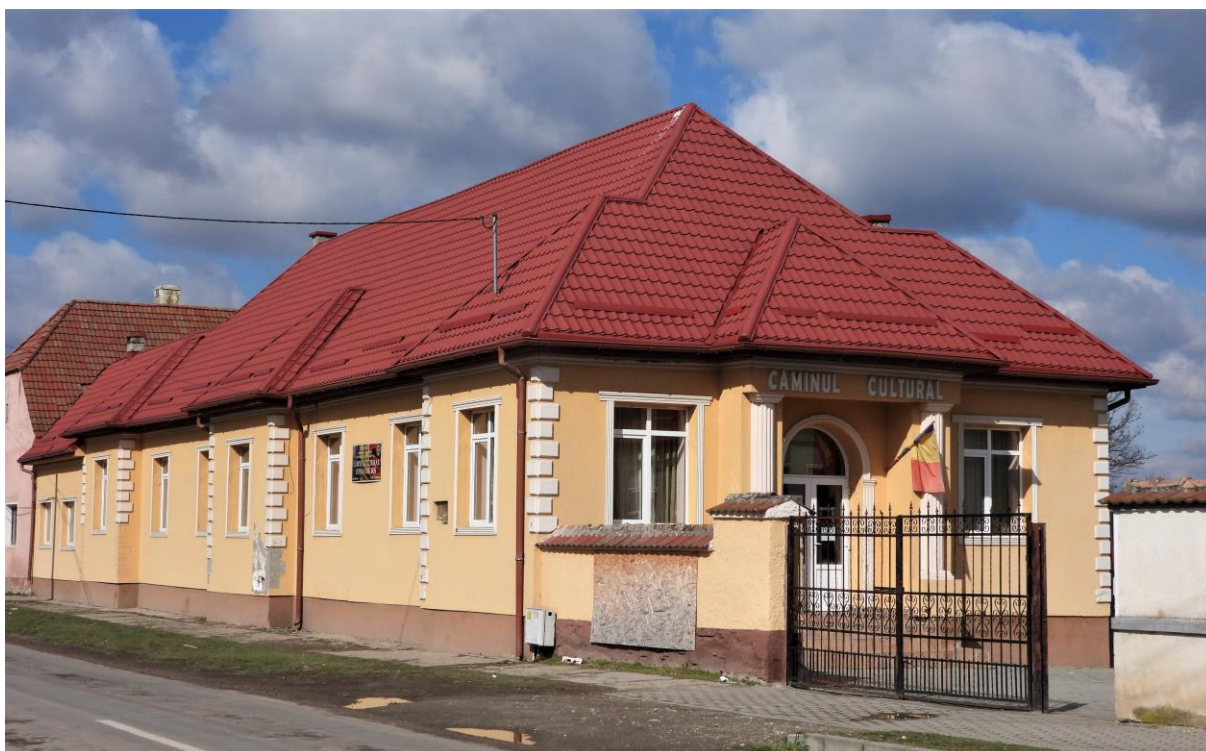
Fig. 11 – Căminul Cultural Comăna de Jos
