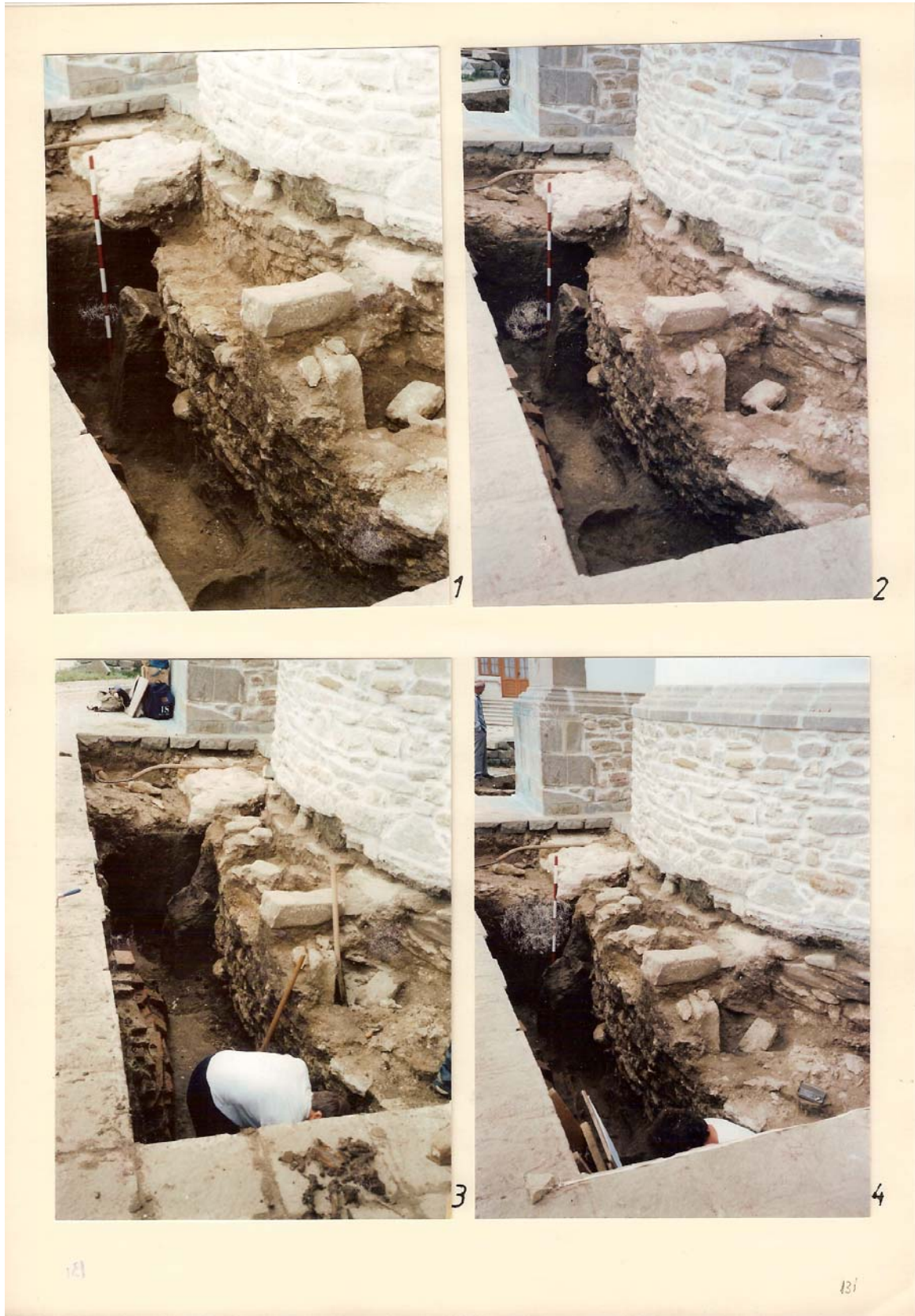
Planşa 125 - 1-4 - Aspect şantier - SI/2003
