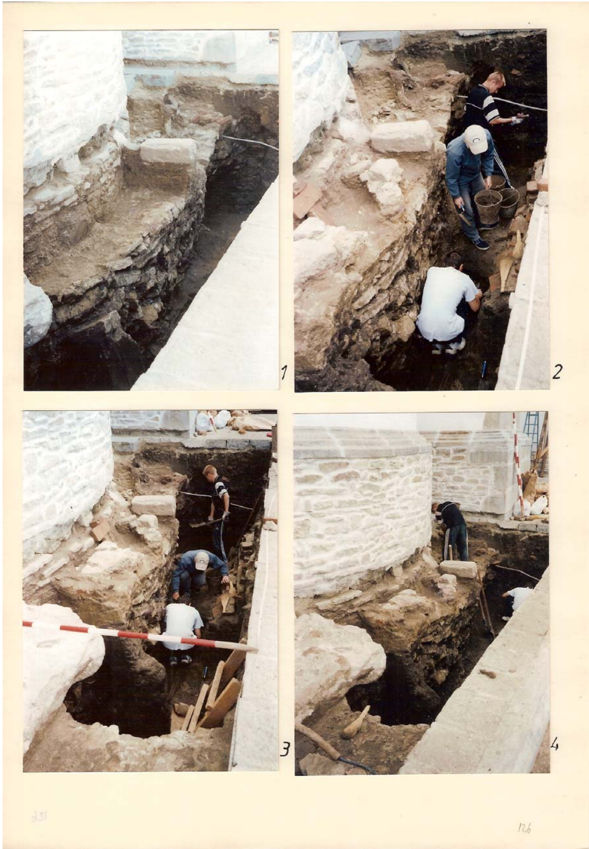
Planşa 80 - 1-4 - Aspect şantier - SI/2003
