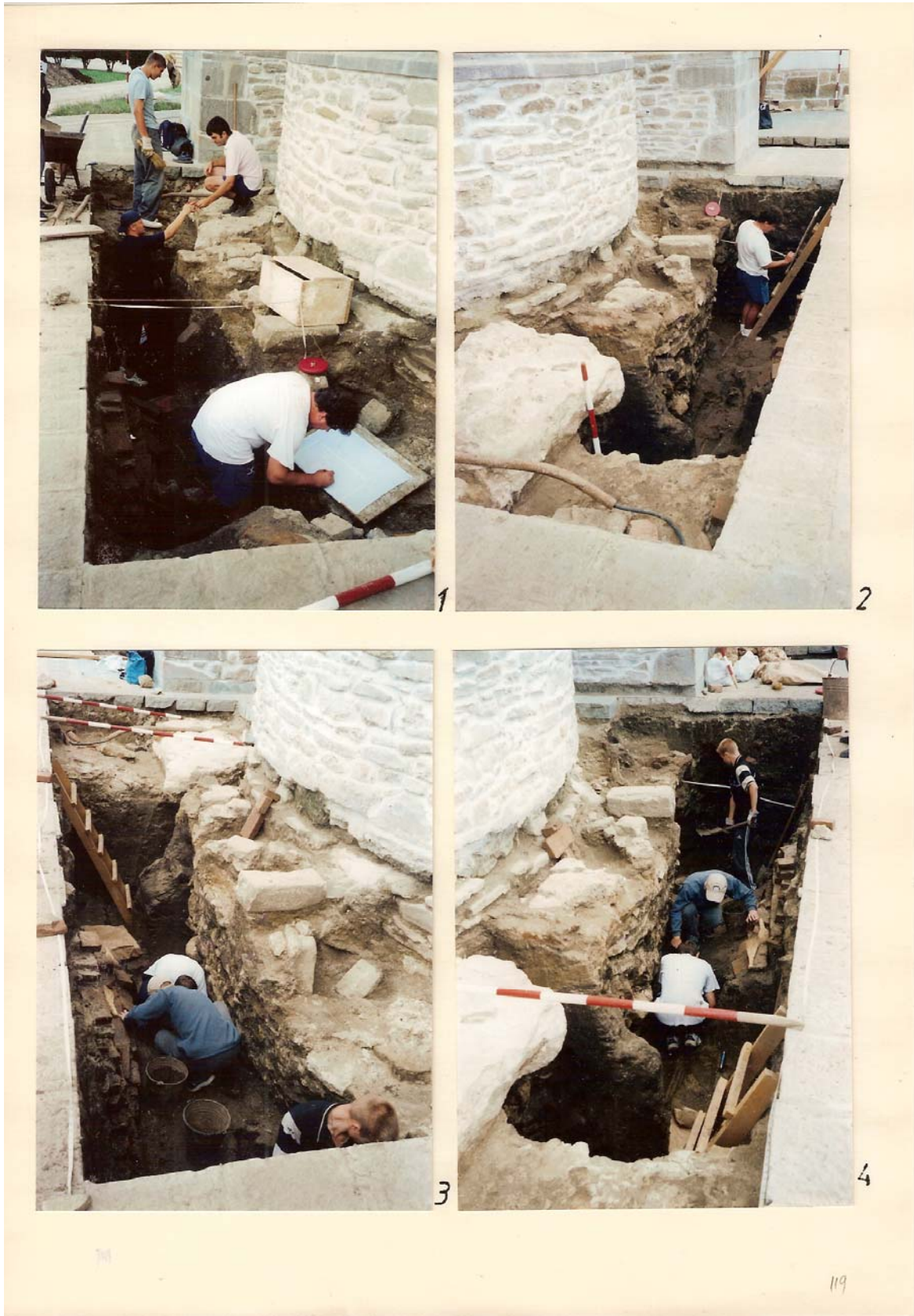
Planşa 122 - 1-4 - Aspecte şantier - SI/2003
