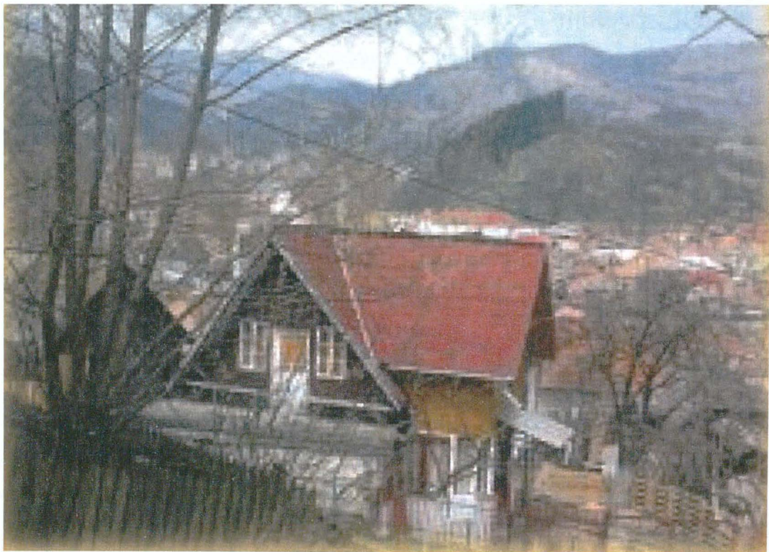
Casa proprietate personală – Peste Vale din Rucăr - Muscel
