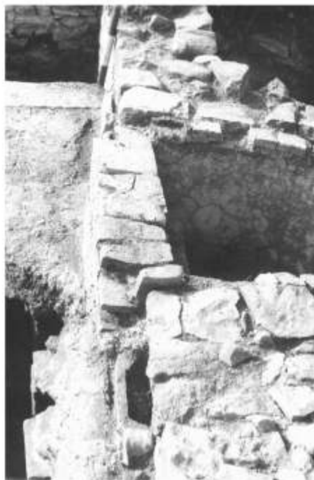
Fig. 20. Obiectiv no 2. Tegulae mammatae in situ.
