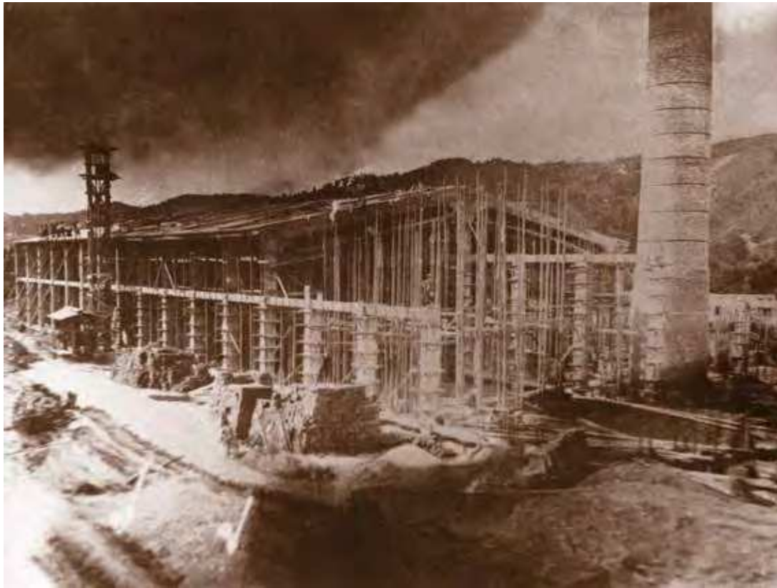
Construcția halei cuptoarelor, prevăzută să adăpostească două cuptoare, 1919.
