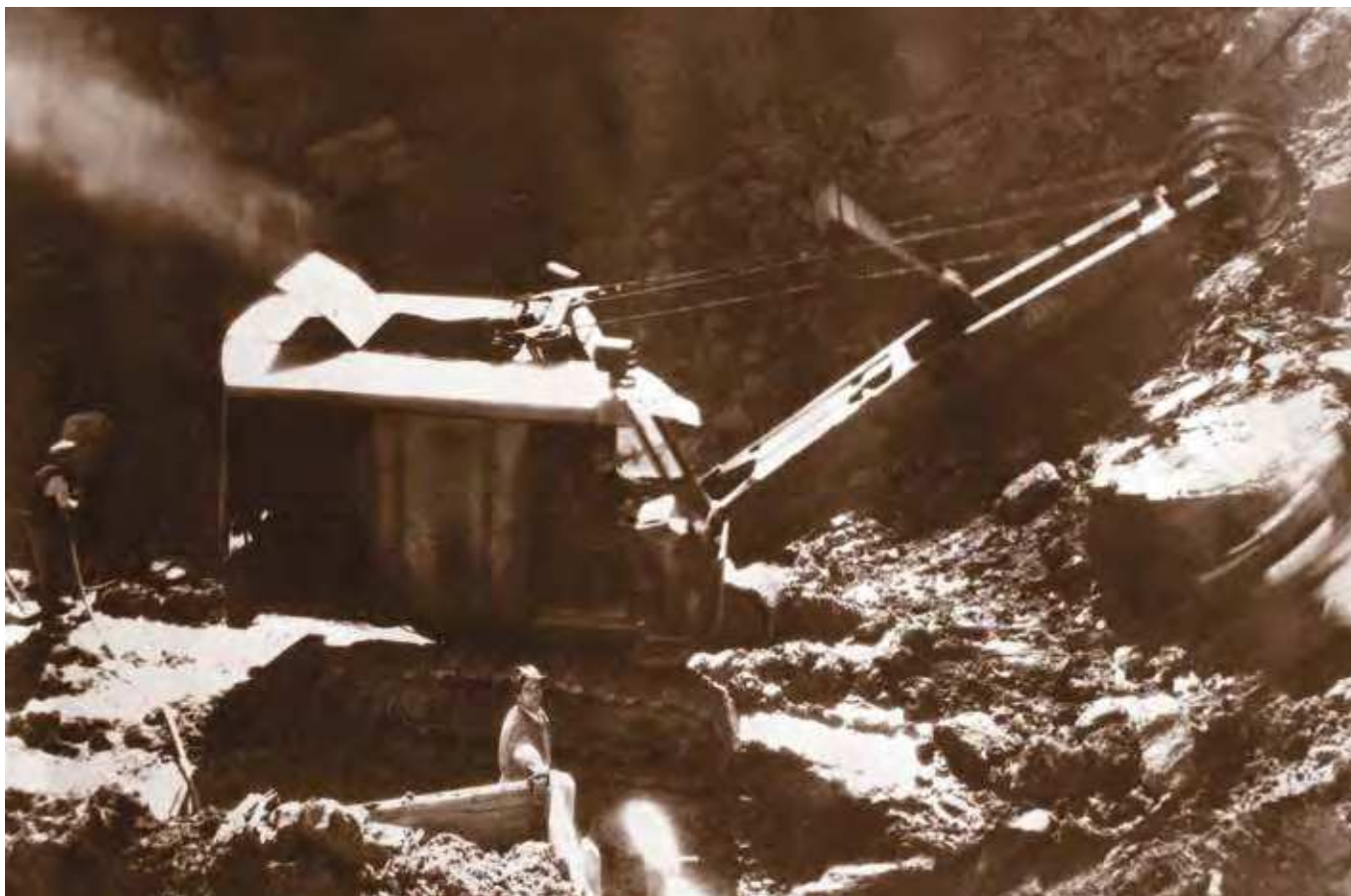
Excavator în cariera Lespezi
