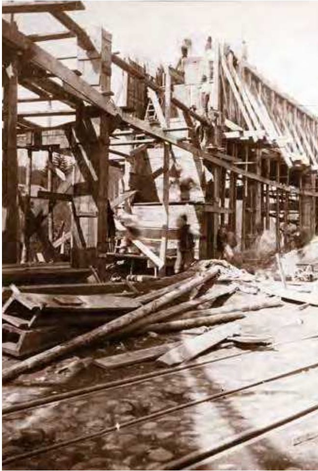
Cofrag la canalul de apă construit până în 1920, prin care apa din râul lalomița este trimisă turbinelor de tip I. M. Voith.
