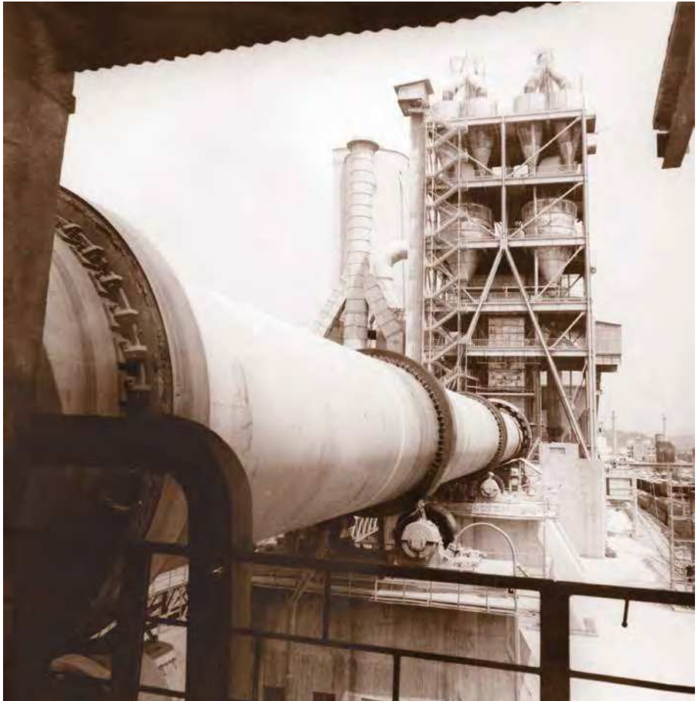
Cuptorul nr. 7 finalizat, vedere spre turnul cicloanelor.
