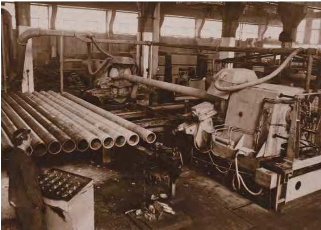
Instalația pentru fabricarea tuburilor de azbociment – strunjire – finisare
