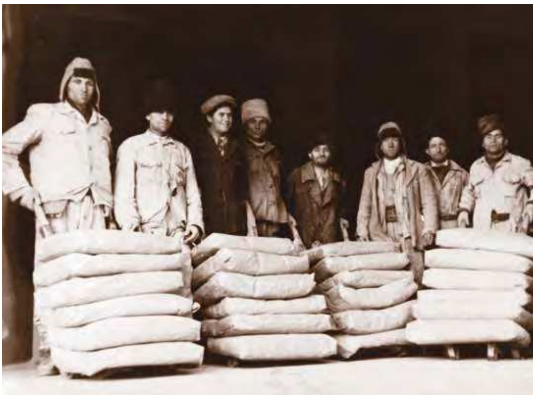
Transportul cimentului înscuit cu cărucioare (lize)
