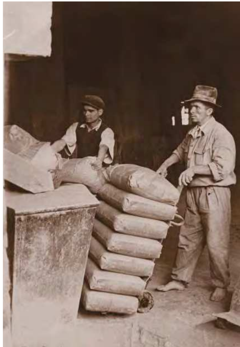
Transportul cimentului însăcuit cu lize
