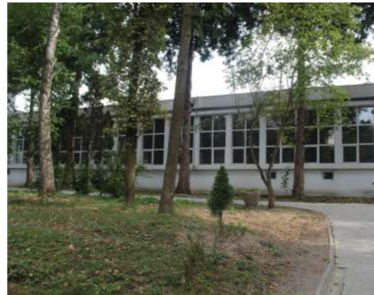
Corp de clădire cu atelierul de tâmplărie
