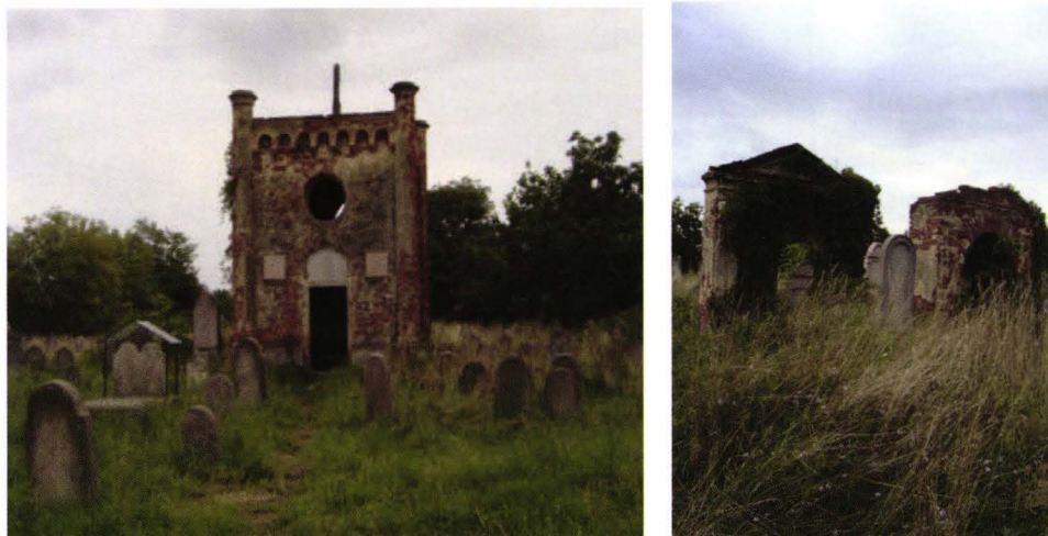
Fig. 38. Ruine de capele cimiteriale din cimitirul evreiesc vechi din Carei (SM)
