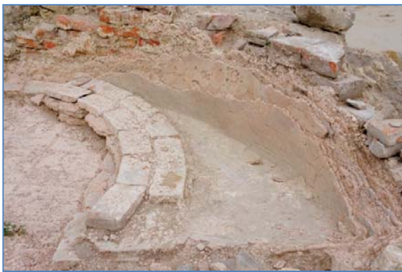
Figura 9. Straturile succesive de tencuială hidrofugă de pe peretele din interiorul absidei
